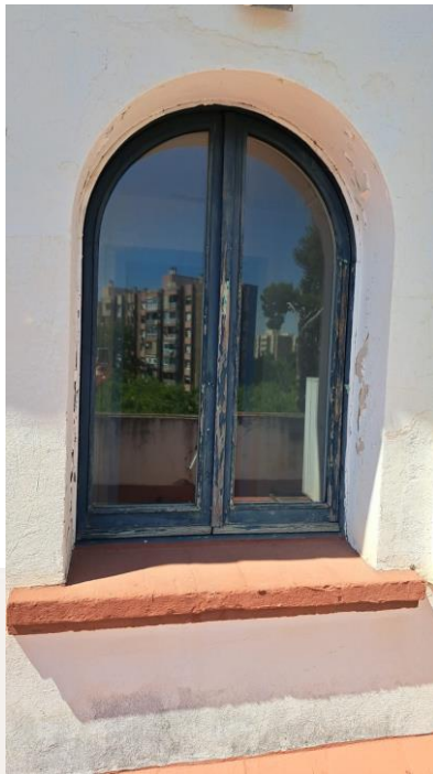
Foto 5– Fusteria deteriorades
