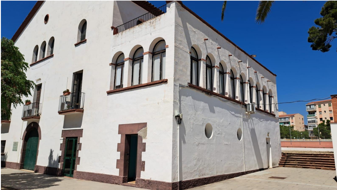
Foto 1 – Façana exterior principal de l'edifici situat a Can Sellares, Viladecans
