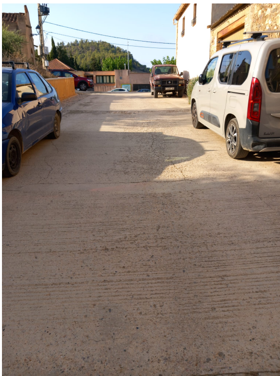
Carrer Nou Priorat
