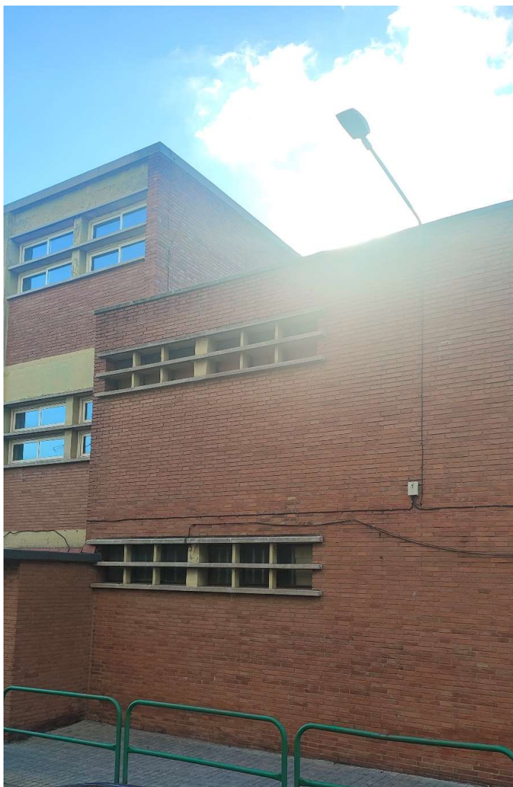
Fig. 14 Zona ubicació futura TFM.
