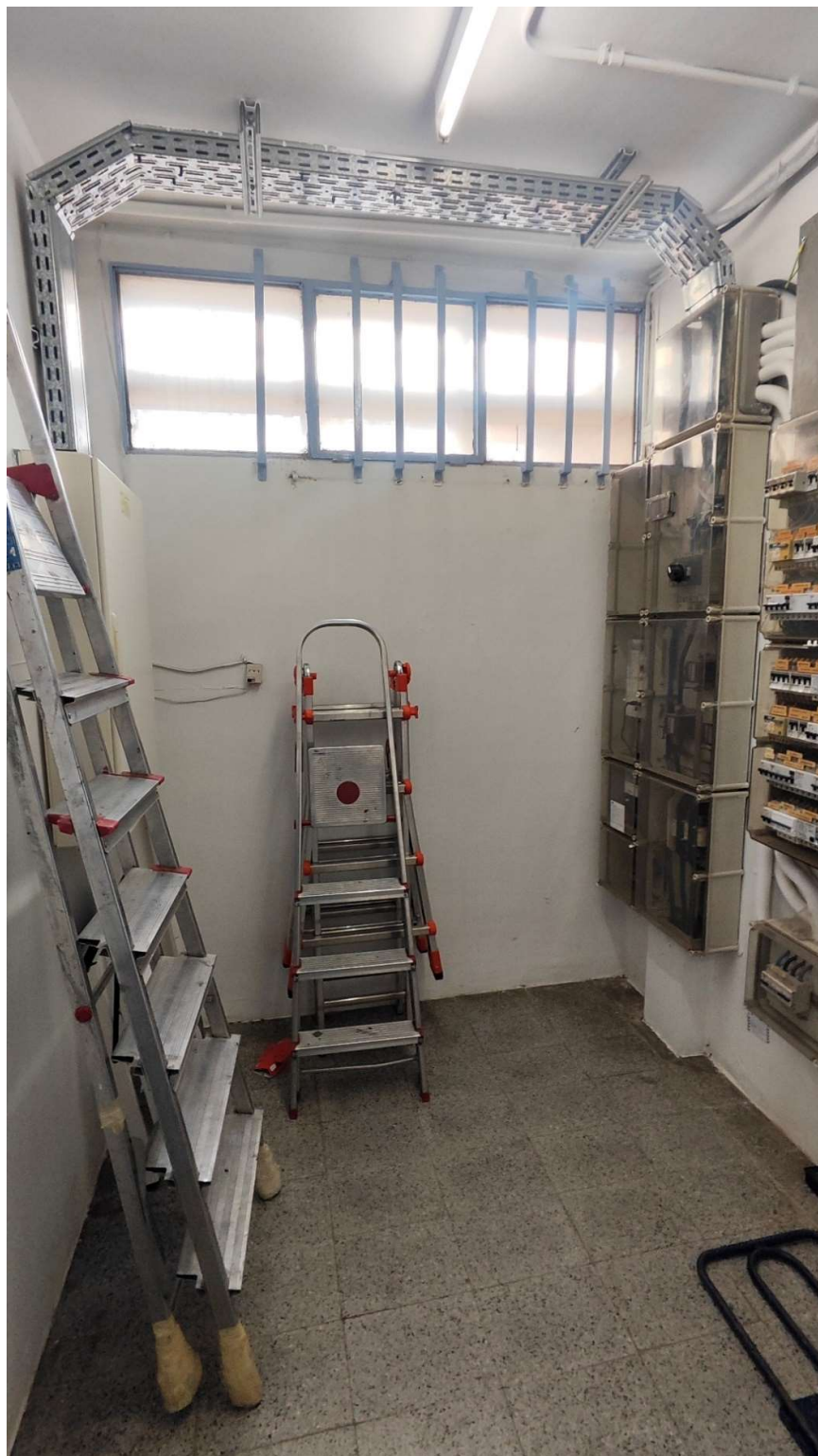
Fig. 13 Vista de la sala d'equips on s'ubicarà el quadre de proteccions FV-CC. Com es mostra als plànols la paret del fons d'aquesta sala es mourà a fi d'encabir l'armari on s'ubicaran les TMFs el qual serà accessible des del carrer per part de la companyia elèctrica.
