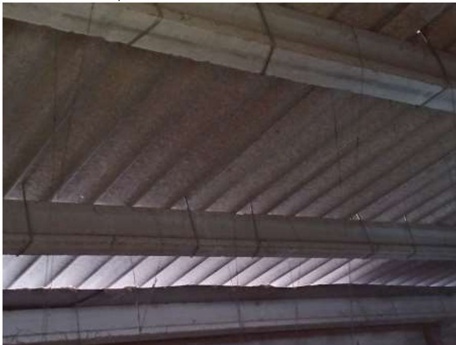
03 Coberta sala, vista des de l'interior del fals sostre
