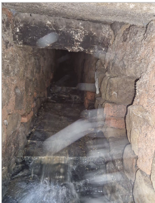
Fotografia 1. Tram col·lector maçoneria 500 x 700 mm
