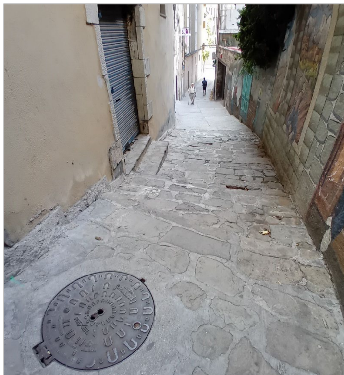
Fotografia 2. Pou inici tram col·lector a renovar
