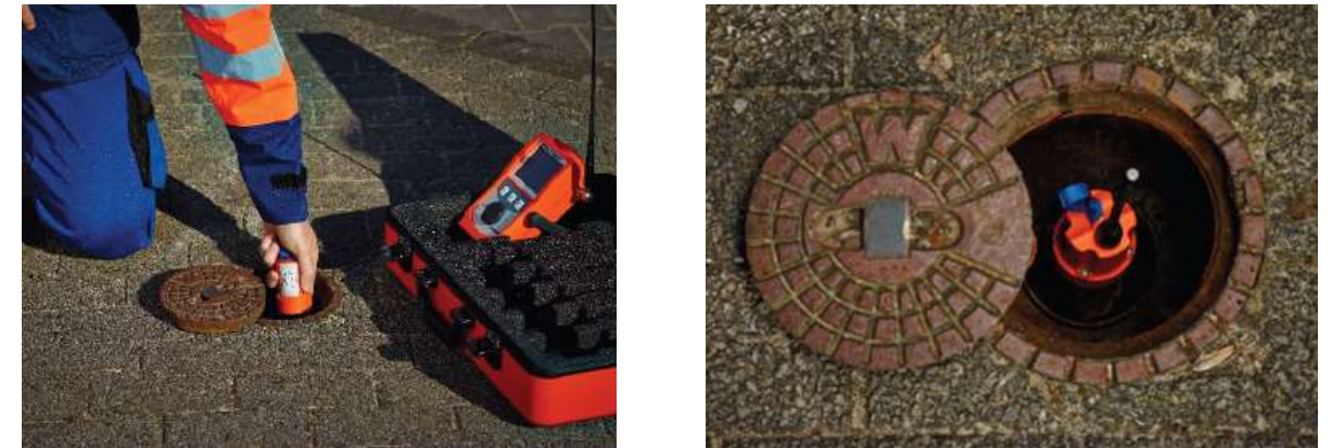
Figura 12. Instal·lació del detector acústic en arqueta existent.
