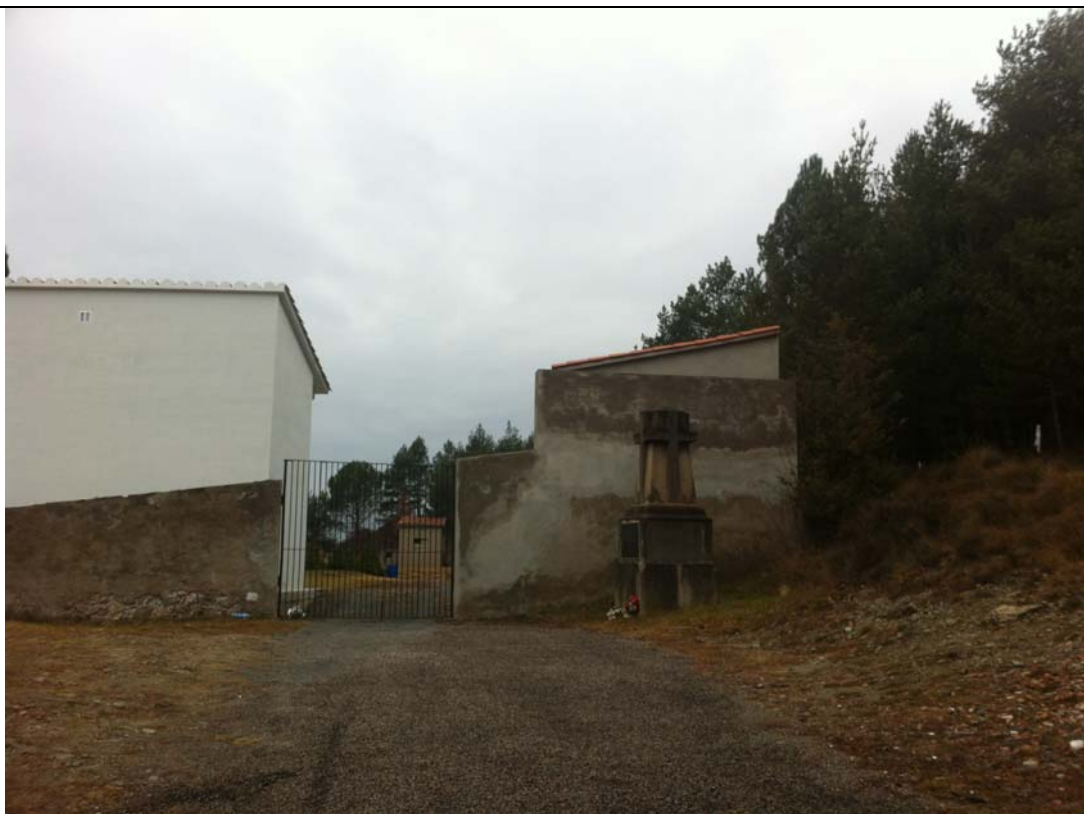
Vista cementiri des de l'accés lateral nord
