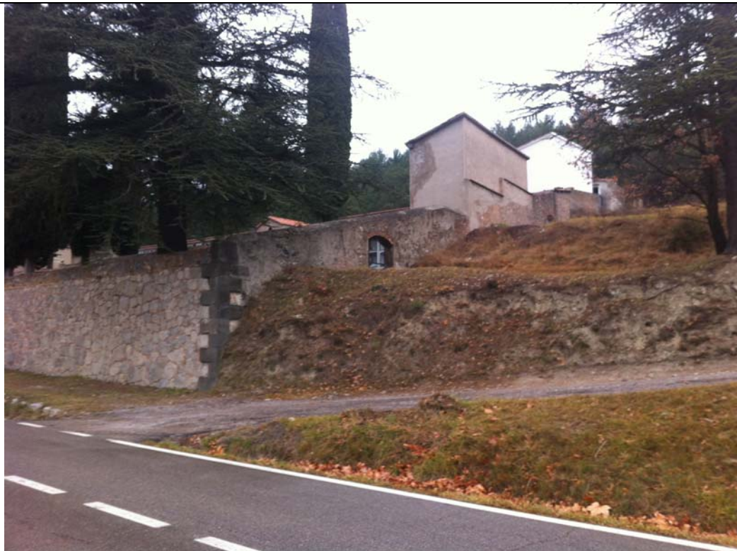
Vista cementiri des de la carretera B402 i camí accés lateral .
