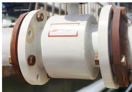
Cuerpo acero con recubrimiento Epoxy
