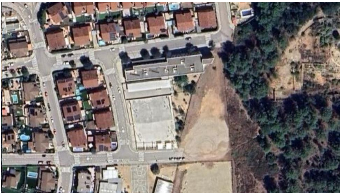
Il·lustració 1: Vista superior de l'edifici. Google Maps.
