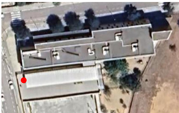
Il·lustració 17: Accés a la pèrgola i escala utilitzada
