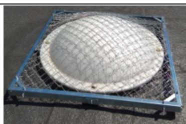
Figura 3. Ejemplo protección claraboyas con enrejado
