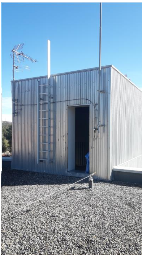
Il·lustració 6: Accés a la coberta
