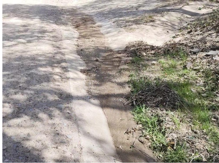
IMG 14. Trobada de les cunetes descrites.
