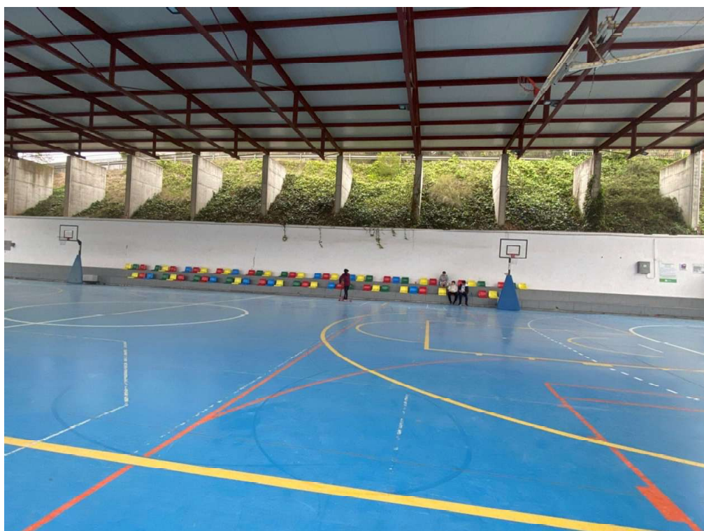
Pista poliesportiva, laterals Est i Oest
