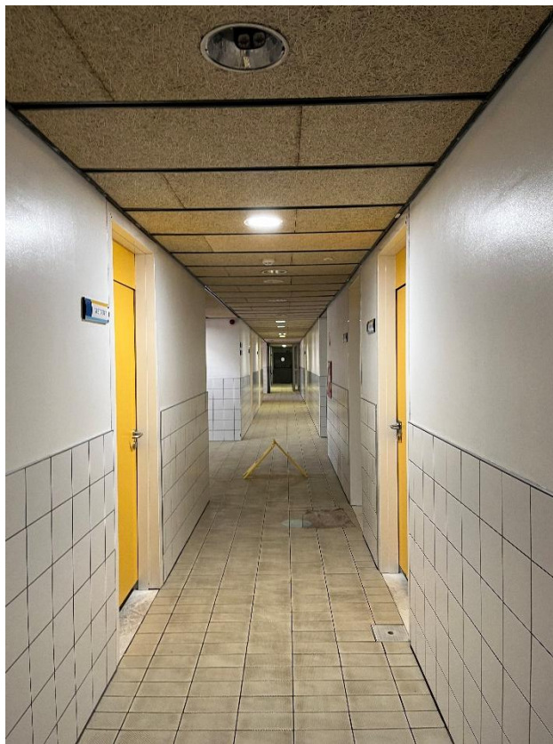
Passadís zona de vestidors planta soterrani
