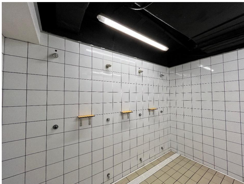
Zona de dutxes del vestidor 4 de la planta soterrani
