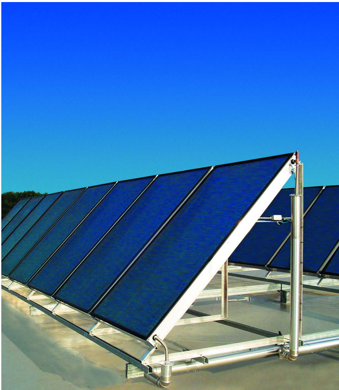
Instalación vertical sobre cubierta plana para una gran demanda térmica
