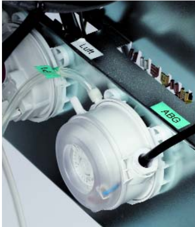
Los presostatos de humos y aire proporcionan un funcionamiento seguro
