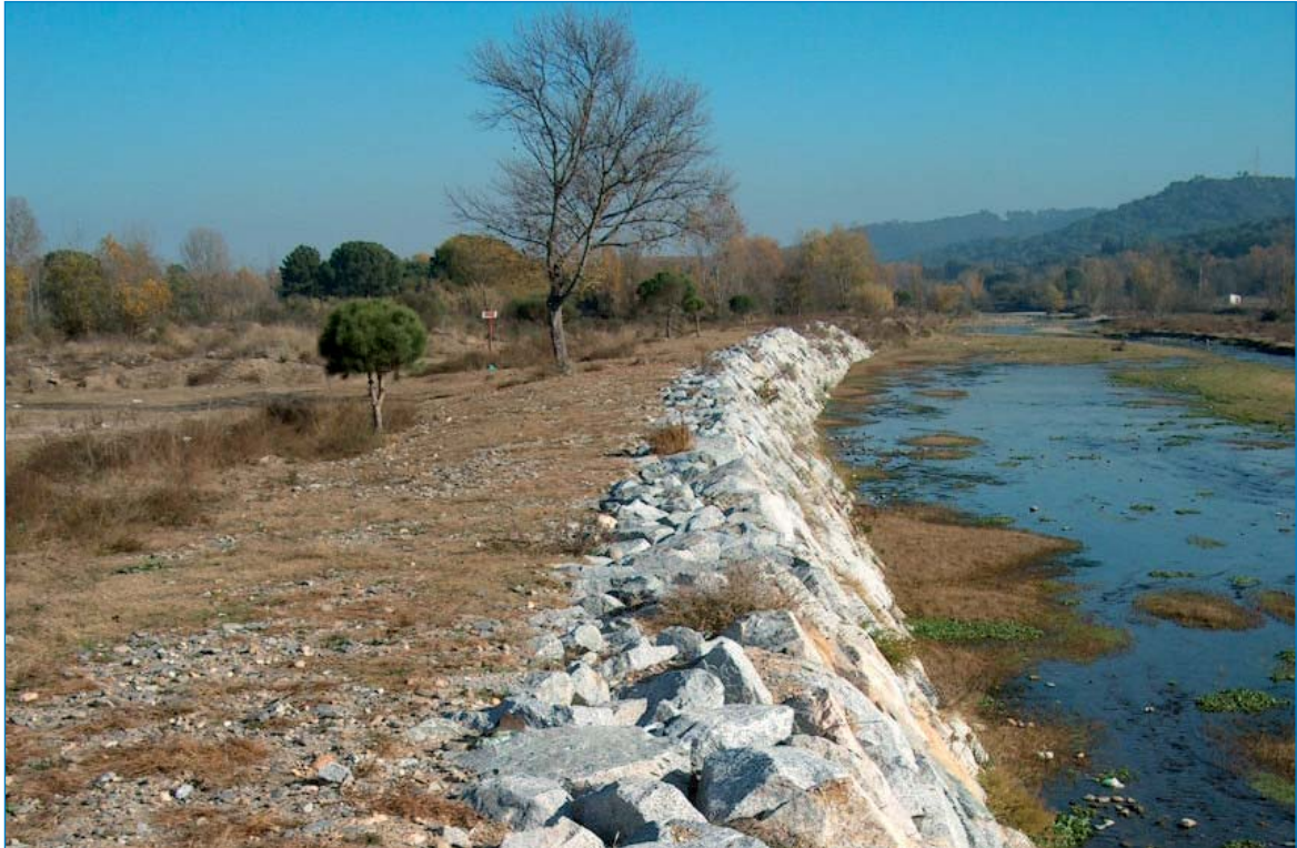
Escullera a les vores de la Tordera. Les alteracions de les morfologies originals de les lleres és un dels impactes més habituals en les riberes.
