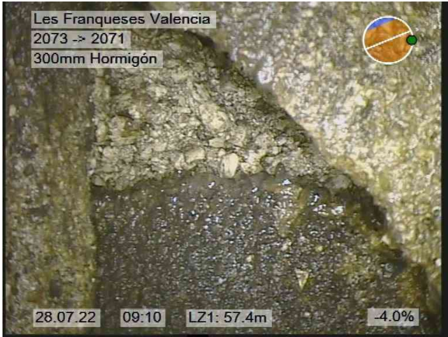
64.jpg, 00:11:21, 57.40m ROTURA PUNTUAL desde 9 Reloj a 3 Reloj
