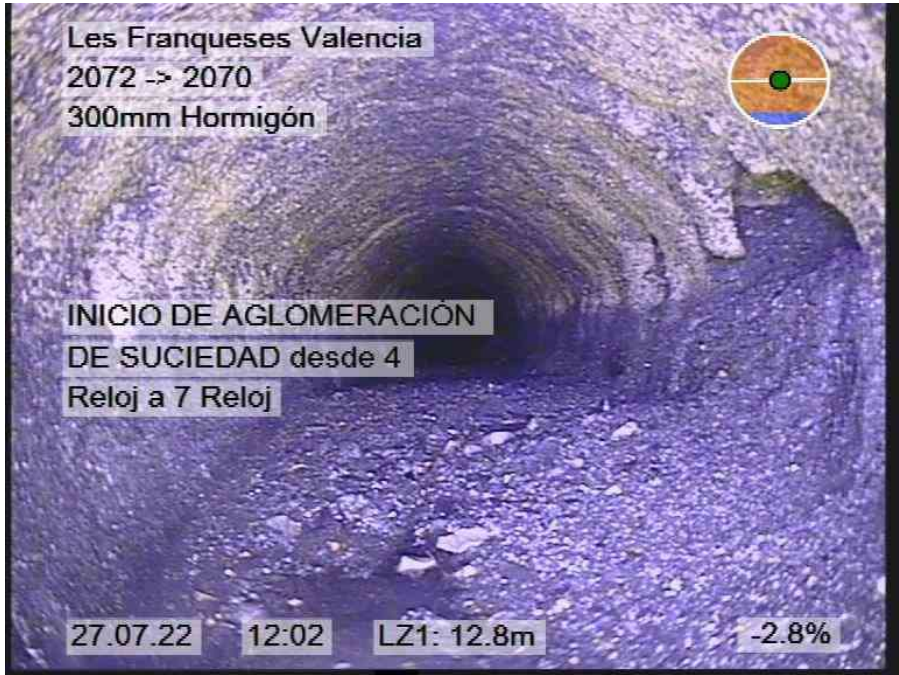
20.jpg, 00:03:47, 12.80m INICIO DE AGLOMERACIÓN DE SUCIEDAD desde 4 Reloj a 7 Reloj
