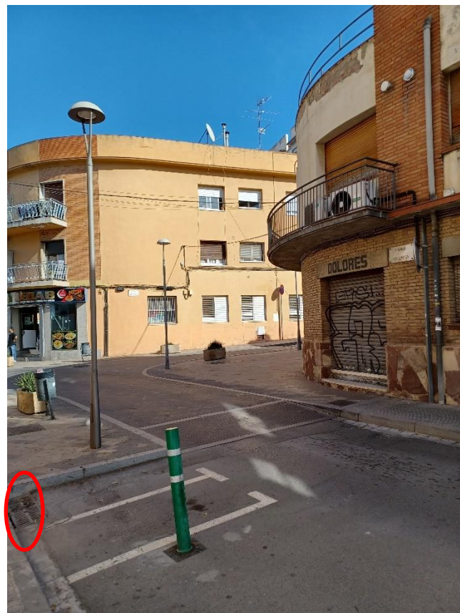
Fotografia 5: Inici del Carrer València, embornal existent connectat a la xarxa
