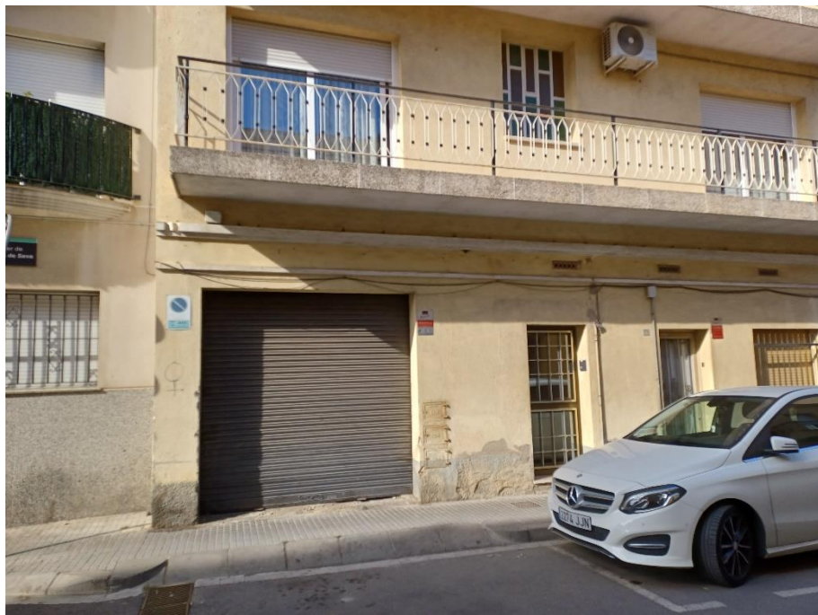
Fotografia 15: Carrer València, qual afectat
