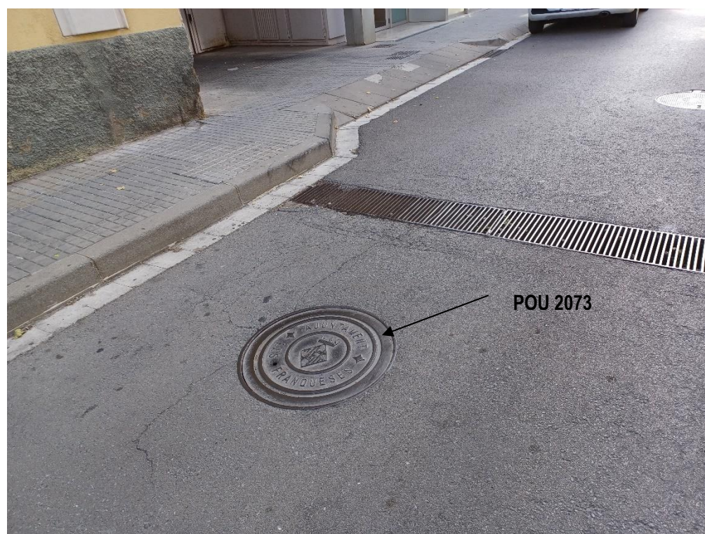
Fotografia 9. Final del carrer Valencia, pou 2073
