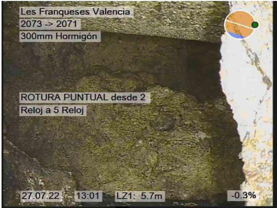
27.jpg, 00:04:39, 5.70m ROTURA PUNTUAL desde 2 Reloj a 5 Reloj
