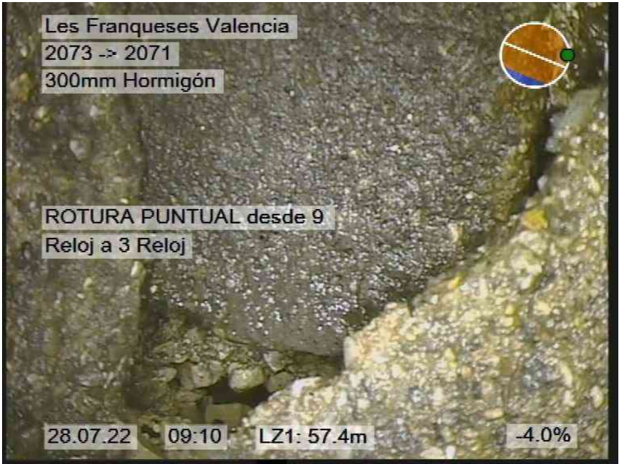
63.jpg, 00:11:21, 57.40m ROTURA PUNTUAL desde 9 Reloj a 3 Reloj
