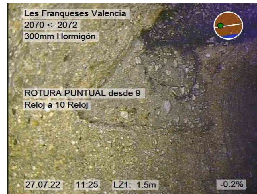
3.jpg, 00:00:09, 1.50m ROTURA PUNTUAL desde 9 Reloj a 10 Reloj
