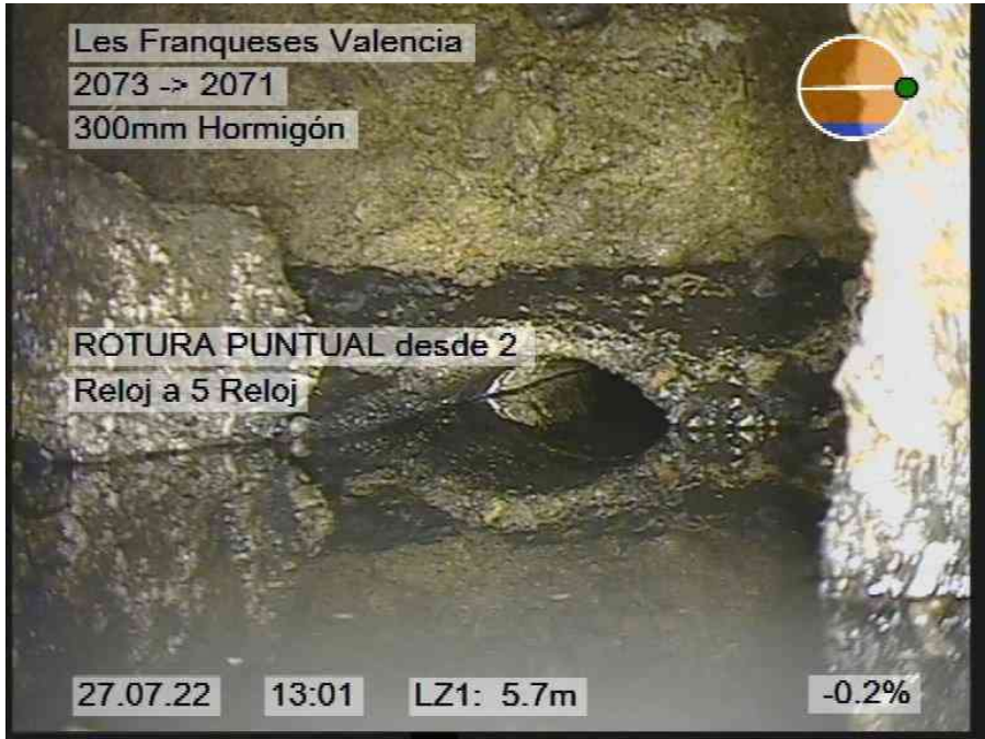
28.jpg, 00:04:39, 5.70m ROTURA PUNTUAL desde 2 Reloj a 5 Reloj
