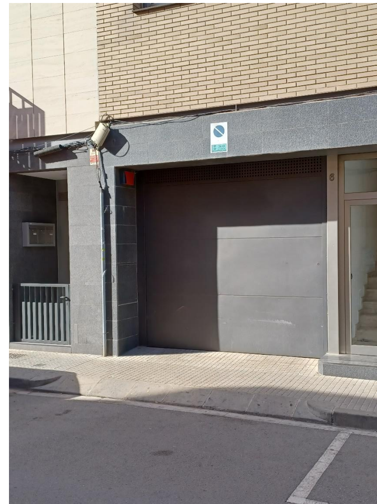
Fotografia 16: Carrer València, qual afectat
