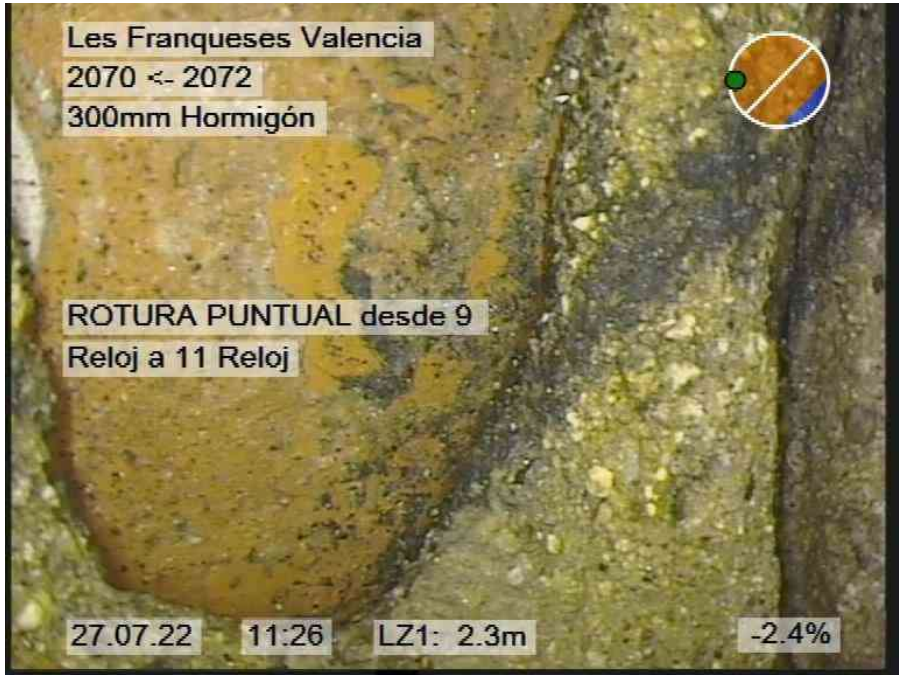
4.jpg, 00:00:36, 2.30m ROTURA PUNTUAL desde 9 Reloj a 11 Reloj
