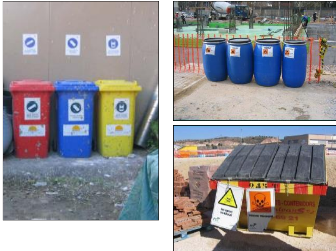
Figura 3. Zones per gestionar els residus dins l'obra
