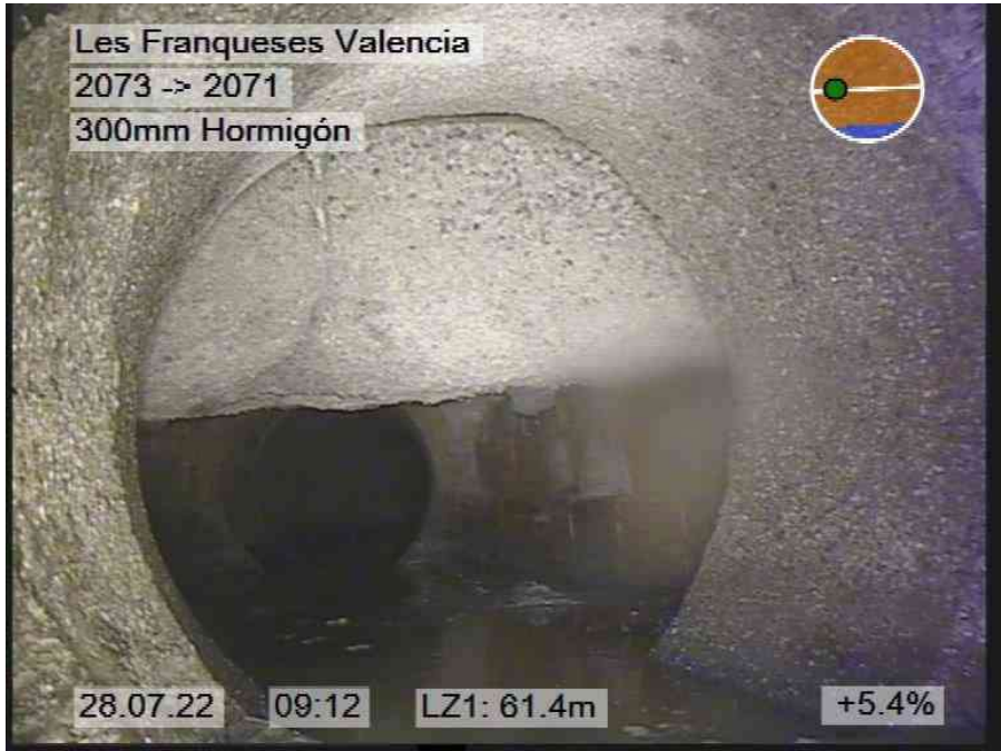
69.jpg, 00:13:01, 61.20m FINAL DE LA INSPECCION
