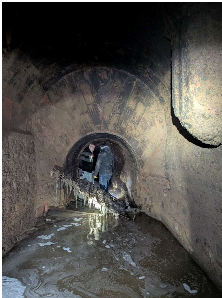
Figura 16. Inici de la galeria i reixa de desbast desencanaixada.
