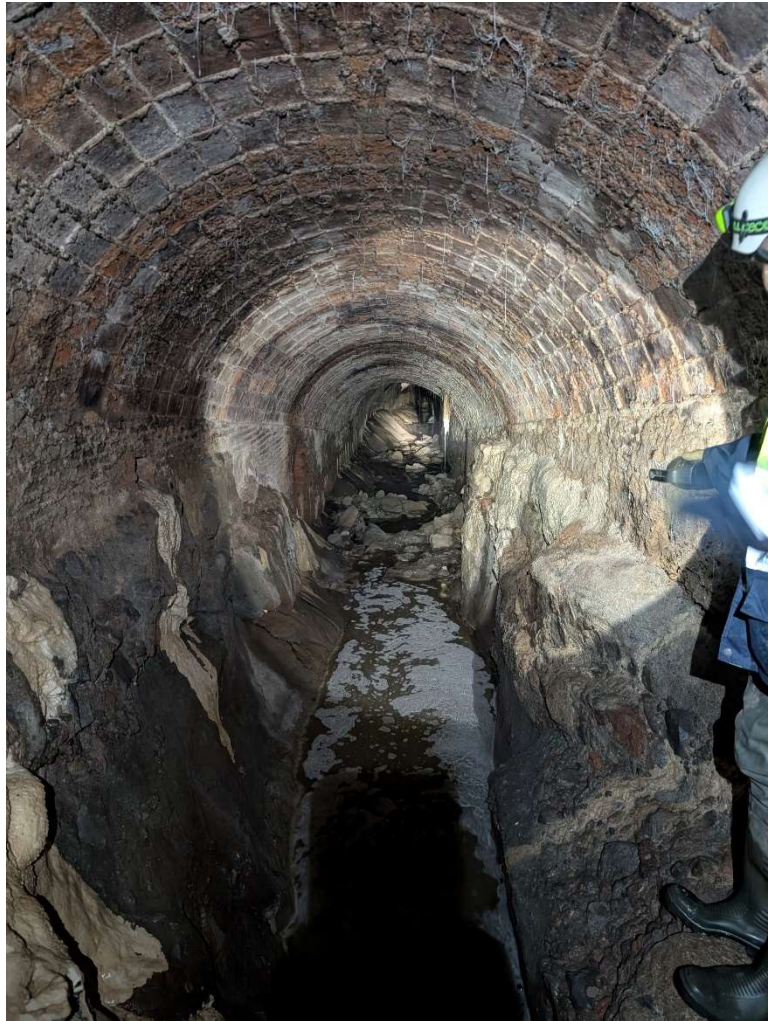
Figura 24. Tram final de galeria excavada a la roca i volta de mamposteria, per sota del Centre Cívic.
