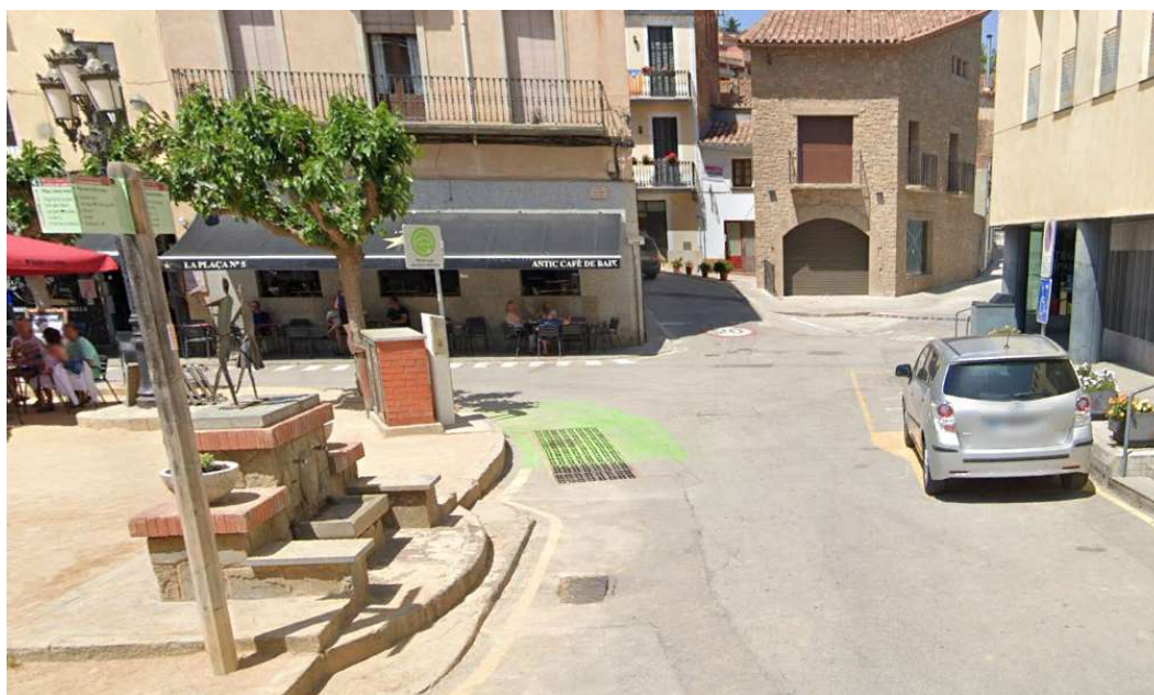
Figura 53. Reixa interceptora, al fons els carrers Sant Pau (esquerre) i Av. Generalitat (dreta)
