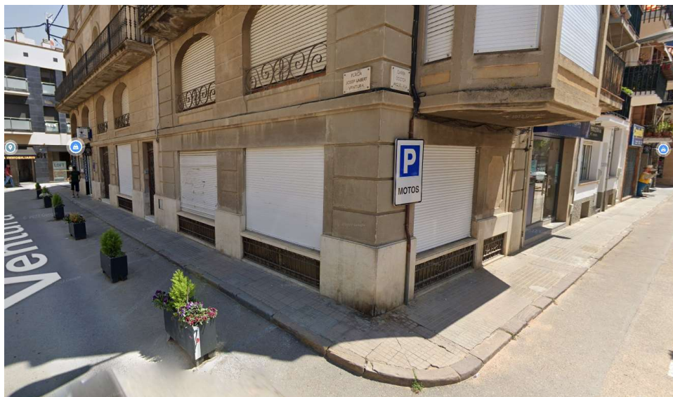
Figura 55. Finestrons baixos a edifici al sud de la plaça Josep Umbert Ventura
