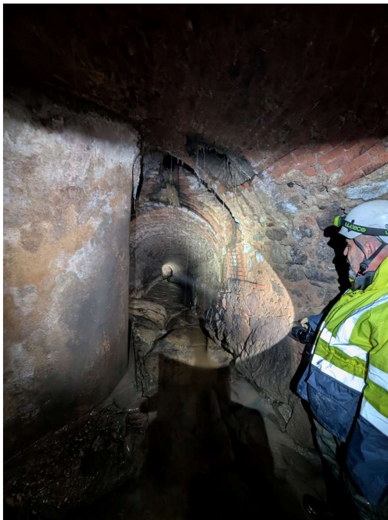
Figura 23. Galeria sota carrer Mossèn Josep Rossell mirant cap a aigües avall.
