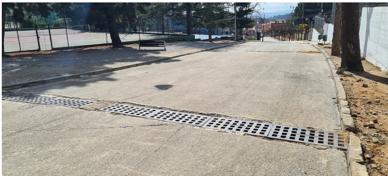
Figura 10. Reixa transversal existent, entre els pous PR-9 i PR9' del Projecte Urbanització UA 6.2 Les Escoles, però no es detecta la presència del pou PR-9 ni de la reixa longitudinal associada que estableix el projecte (veure Figura 9)
