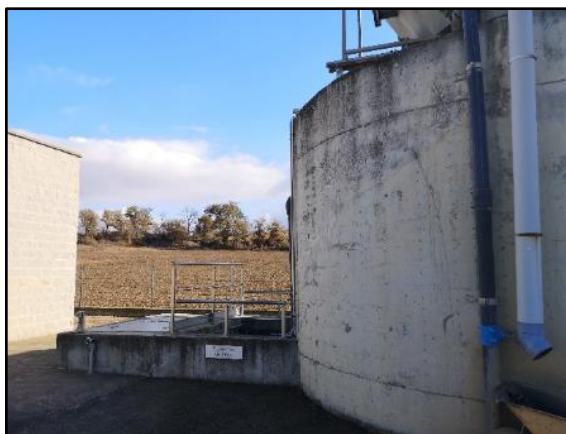
Foto 2 - Espessidor de fangs
