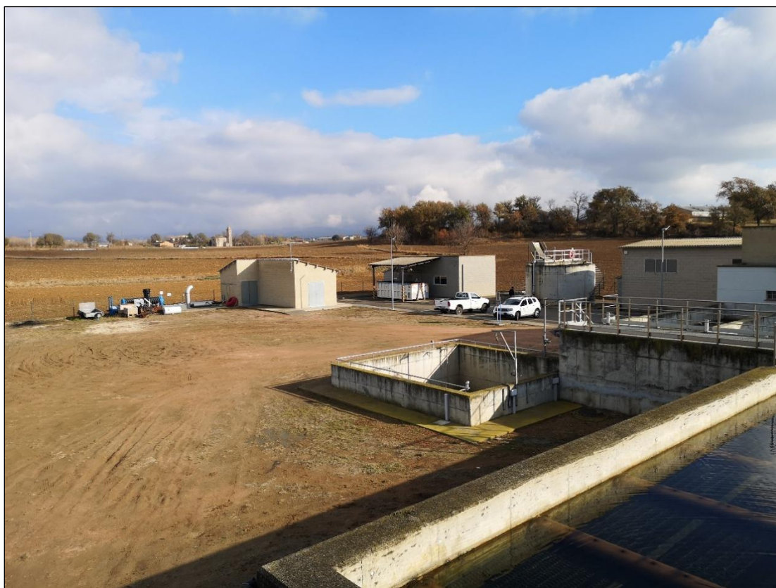
Foto - 1 – Zona prevista d'implantació del nou dipòsit de fangs.
