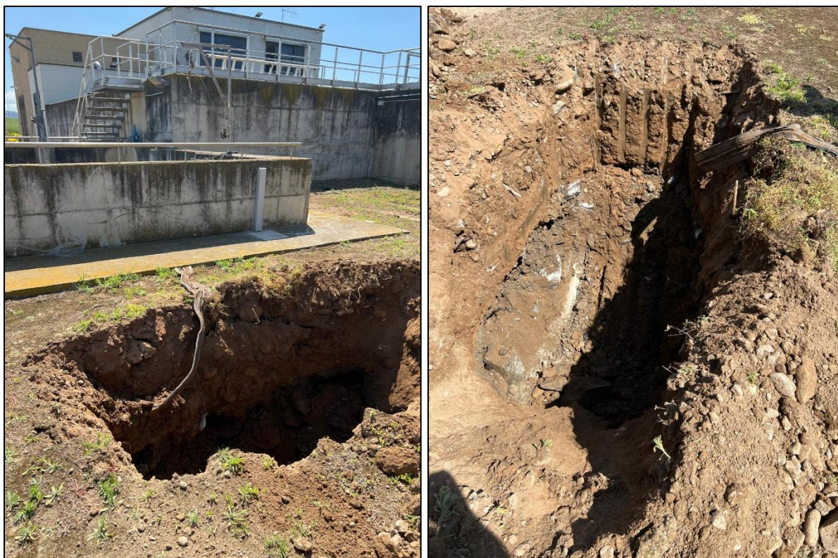
Figura 1. Cala realitzada a la zona prevista d'implantació del nou dipòsit de fangs.
