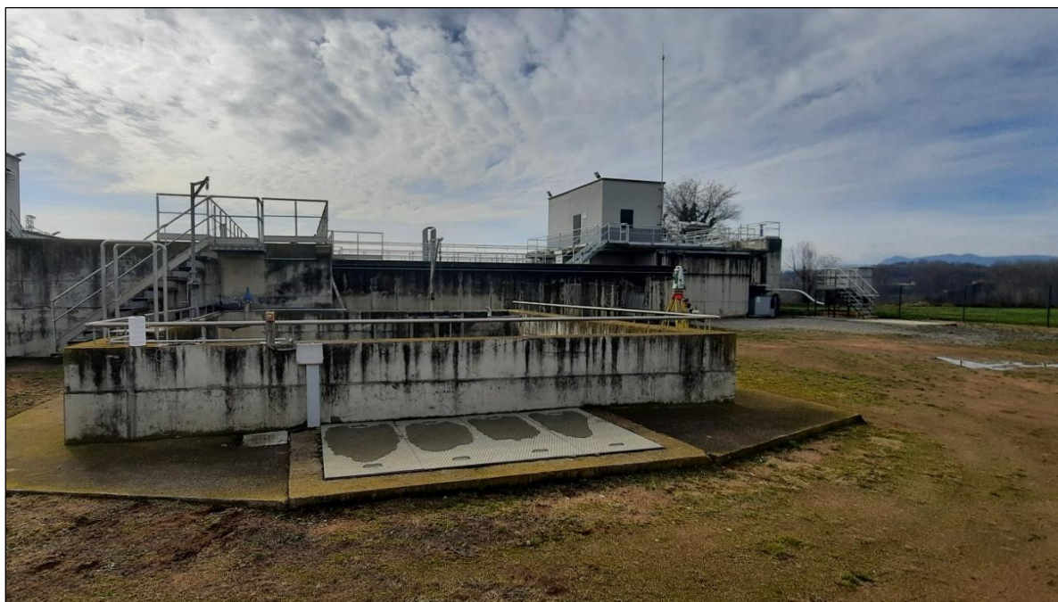
Foto - 2 – Dipòsit regulador de fangs existent i arqueta.
