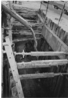
VERTIDO DE HORMIGÓN DE RECUBRIMIENTO
