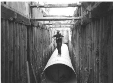
COLOCACIÓN TUBERÍA DE PVC. (RIB-LOC)
