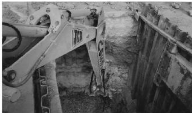
DEMOLICIÓN MECÁNICA EN ZANJA
