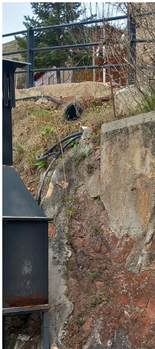
Imatge 3. Sortida del col·lector existent (sense servei)
