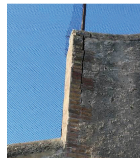
Foto nº1. Esquerra del mur al pk 14+640
