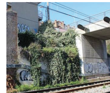
Foto nº2. Mur de formigó i riosta tapats per la vegetació
