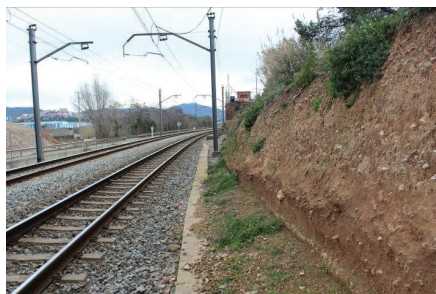
Foto n°2. Lleuger descalçament del tram inicial del talús.
