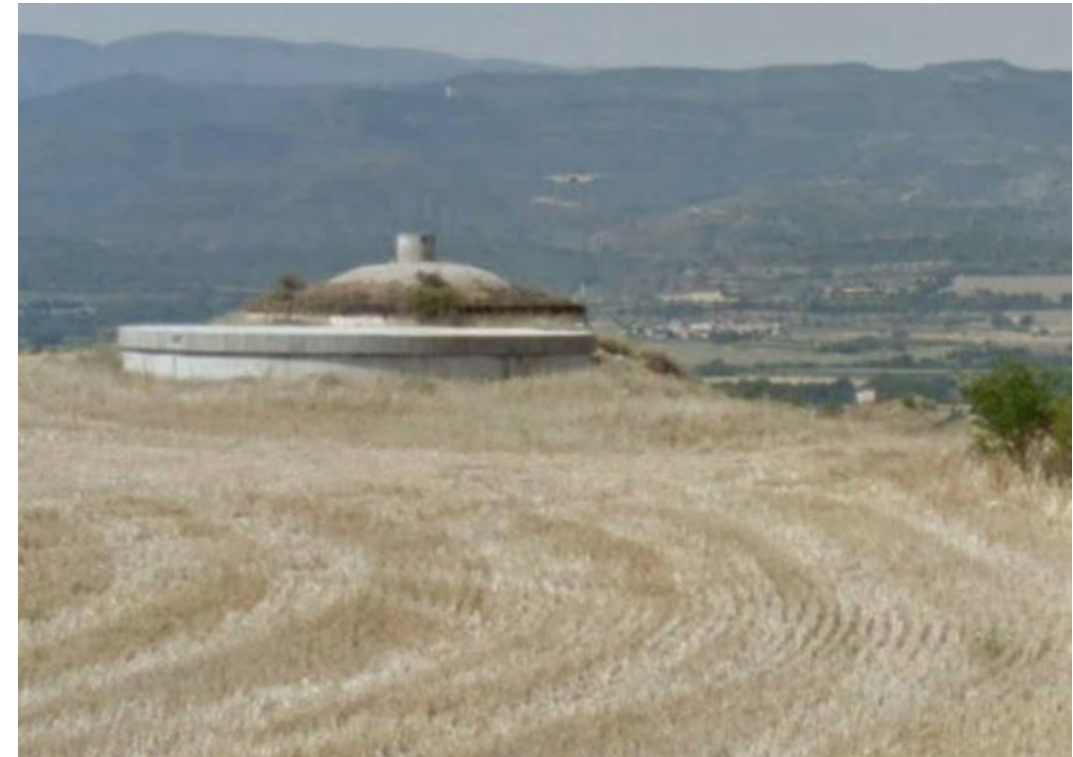
Figura 6. Vista general de la zona de construcció prevista de la nova captació al costat del dipòsit Nou
