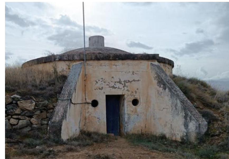
Figura 2. Instal·lacions del dipòsit Vell
