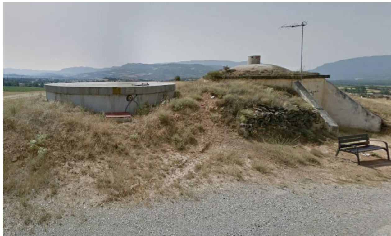
Figura 1. Vista exterior dels dipòsits de Vilamitjana, esquera imatge dipòsit Nou i dreta imatge dipòsit Vell
