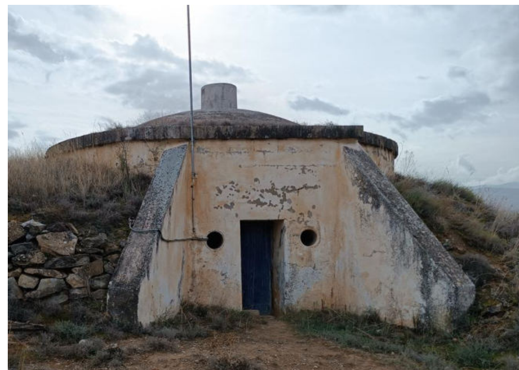
Figura 2. Vista exterior del dipòsit Vell de Vilamitjana
