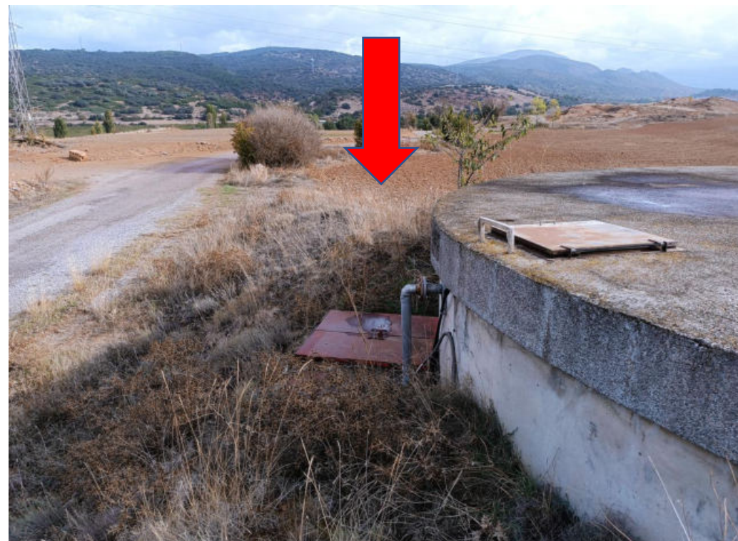
Figura 3. Vista exterior del dipòsit Nou, indicada zona de construcció prevista de la nova captació
