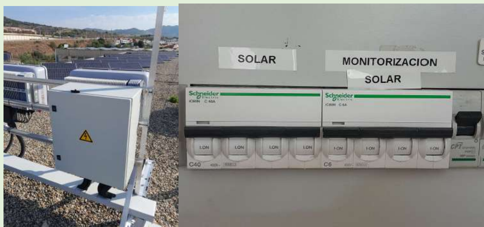
Exemple de quadre i proteccions senyalitzades.
