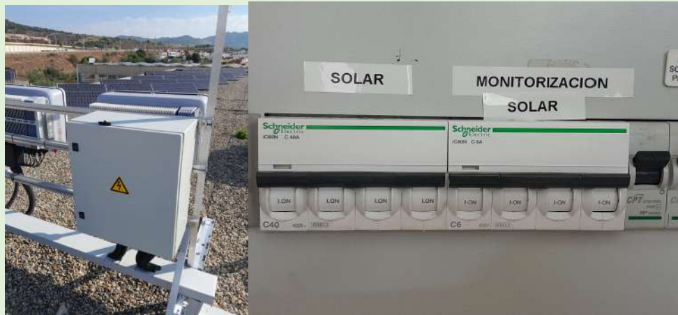
Exemple de quadre i proteccions senyalitzades.
