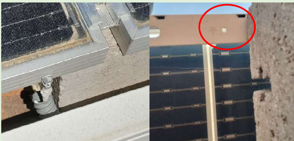
Lateral del marc foradat quan el propi mòdul ja té el forat indicat per instal·lar el terra.
