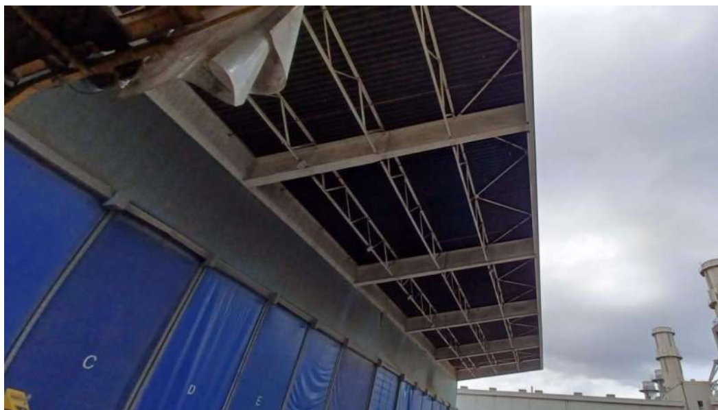
Figura 2h | Estructura en estudio, alero hacia el mar
