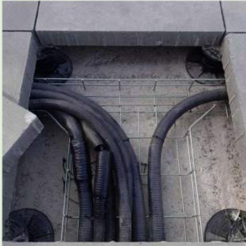
Exemple d'aprofitament del terra tècnic per passar canalitzacions.
