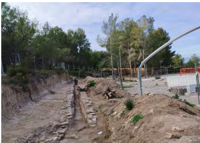
Vista des de l'extrem Est del tram de l'Aqüeducte prèvia al recobriment de graves provisional
