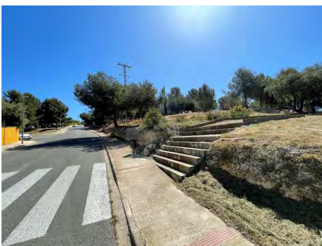
Vista de l'accés per escales des de l'extrem Oest del tram de l'Aqüeducte
