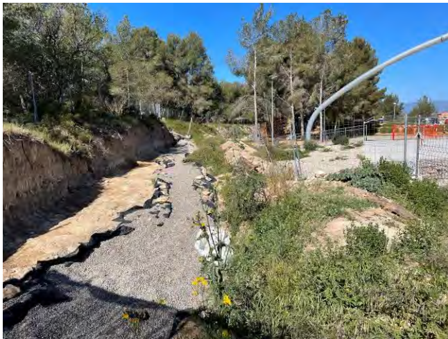
Vista des de l'extrem Est del tram de l'Aqüeducte amb el recobriment de graves provisional
