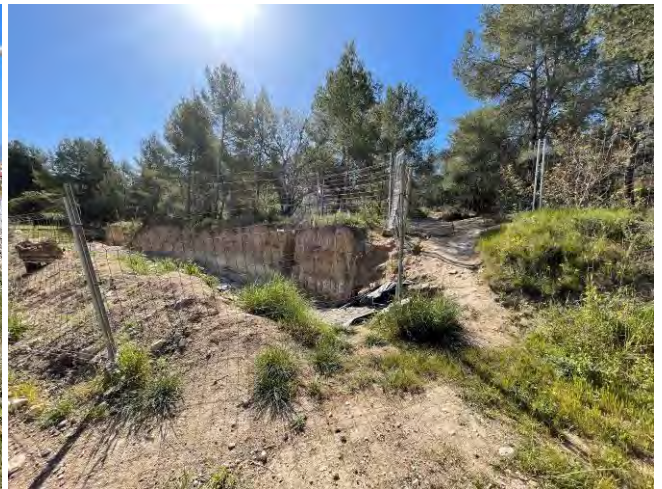
Vista des de l'extrem Oest del tram de l'Aqüeducte
