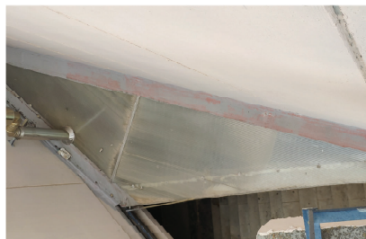
V2 ESTAT ACTUAL
