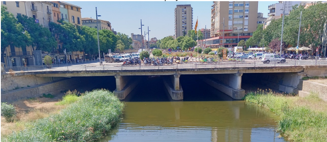
Vista de la Plataforma de Plaça Catalunya des d'aigües avall
