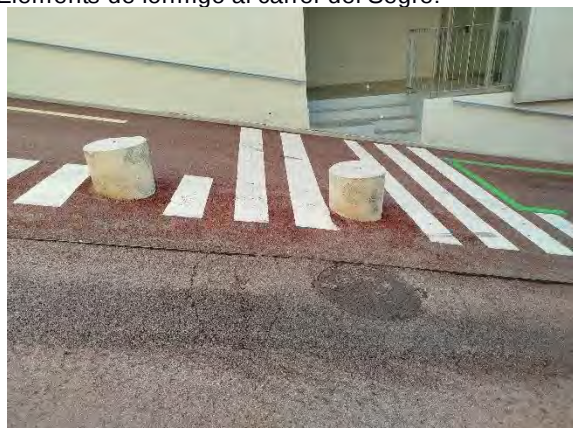
Elements de formigó al carrer del Segre:
