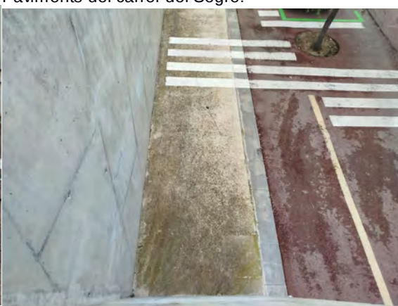
Paviments del carrer del Segre:
