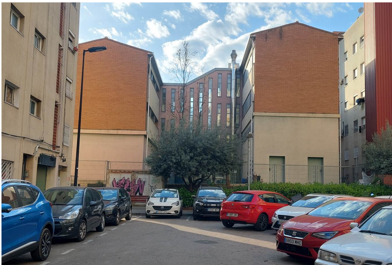
Zona de l'ampliació. Vista des del carrer de La Vinyala.
