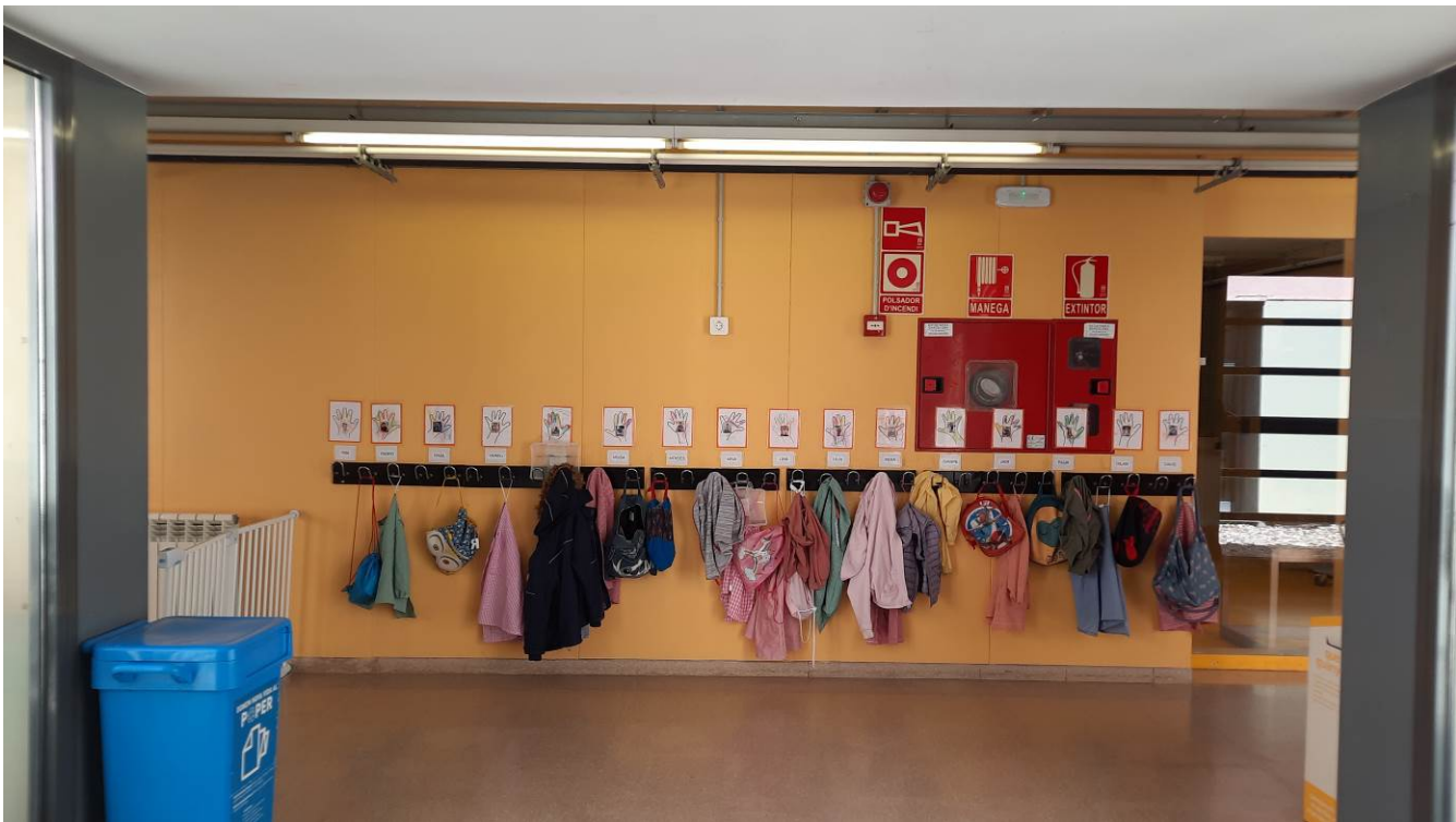
Passadís d'infantil en la zona d'intervenció. Elements de Protecció Contraincendis.
