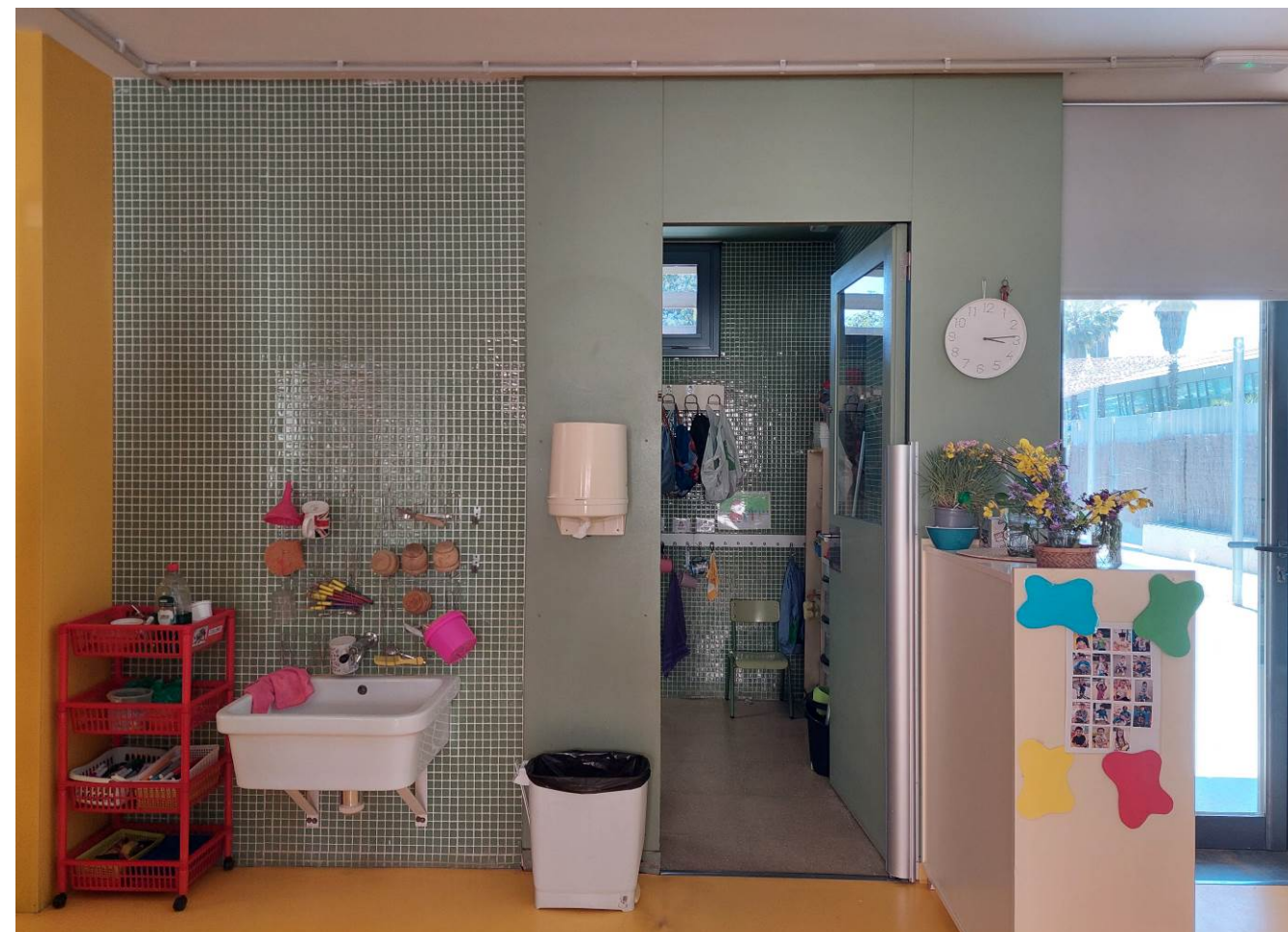
Porta accés a lavabos integrada en revestiment de fusta
