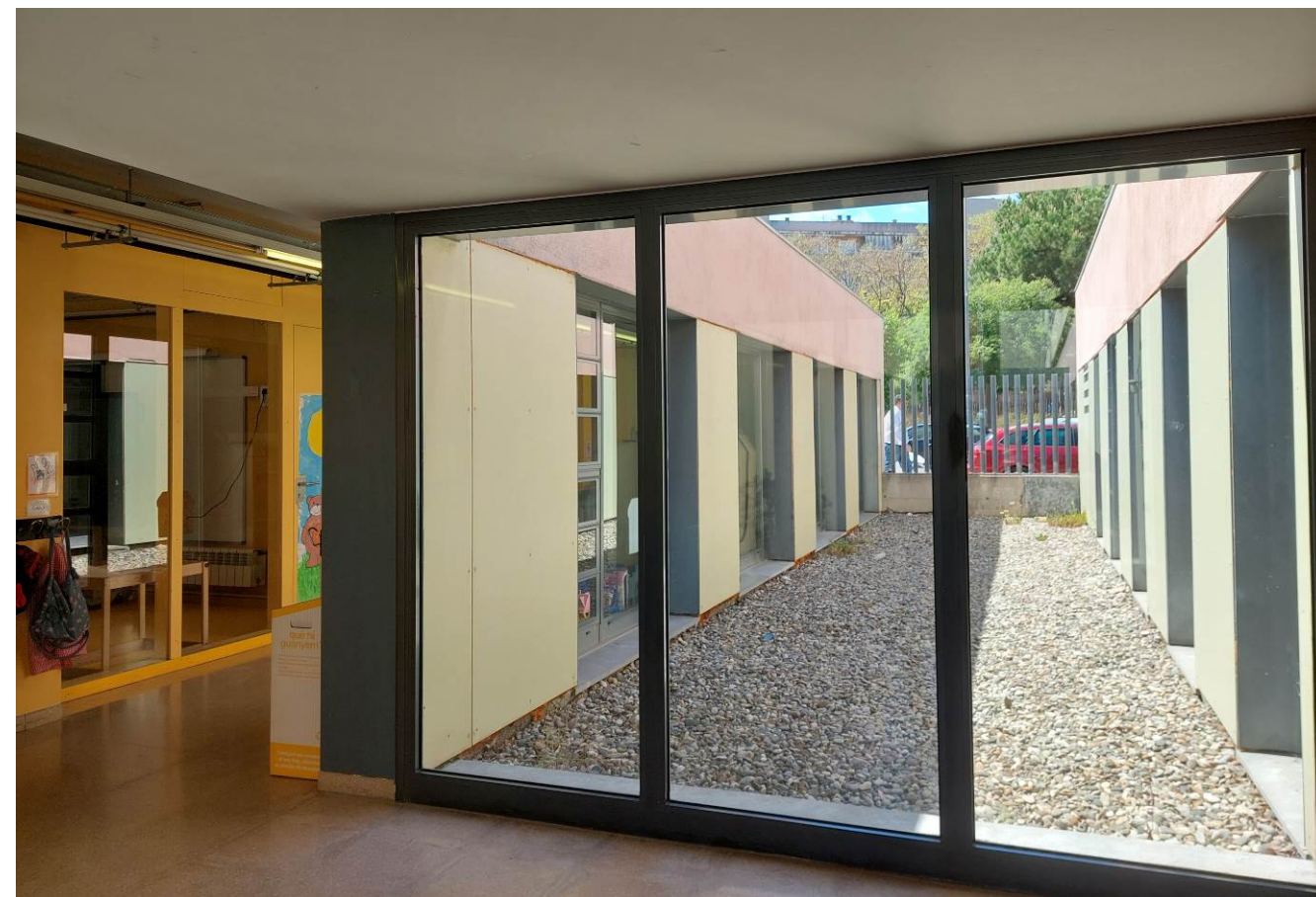
Zona de connexió entre passadís aules i aula de psicomotricitat.
