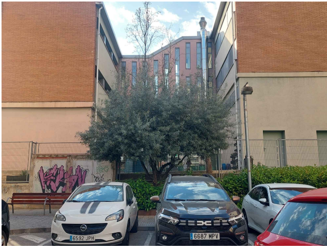
FAÇANA SUD EDIFICI ORIGINAL
