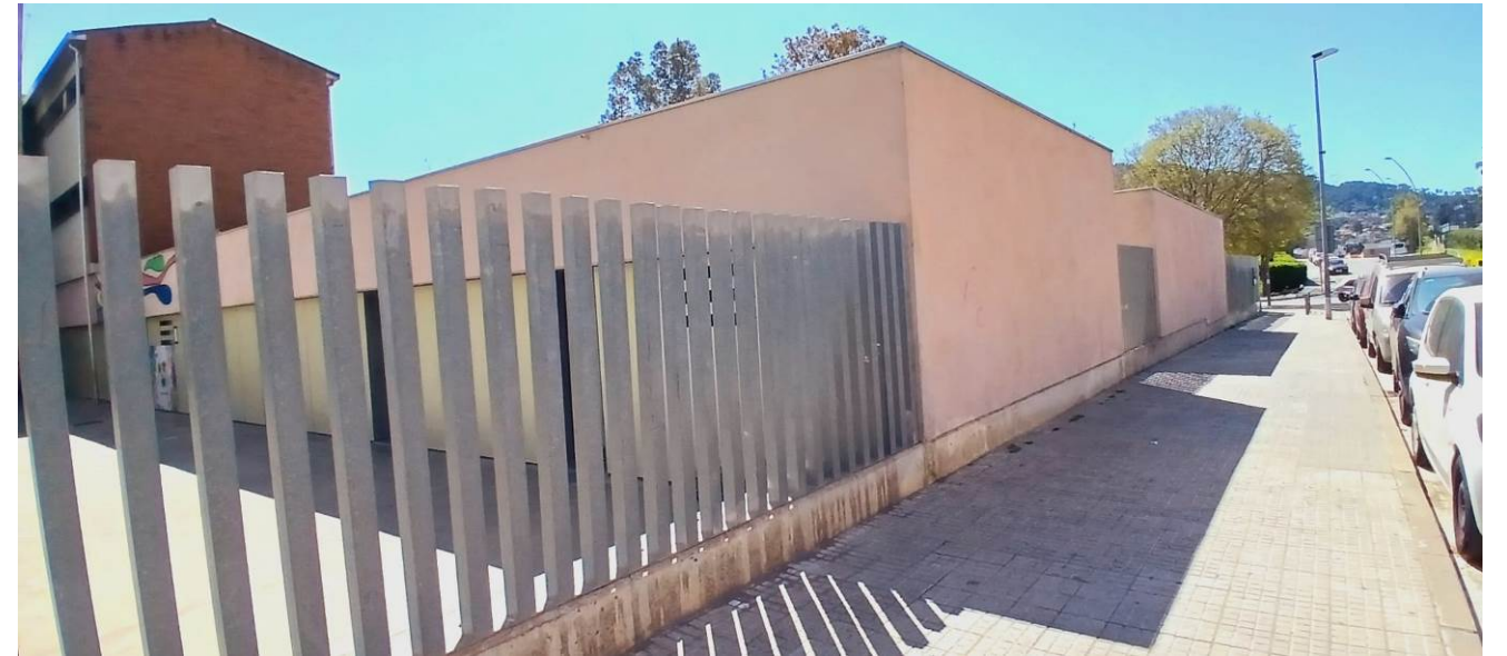
Vista de l'edifici d'infantil des del carrer Sant Josep.
