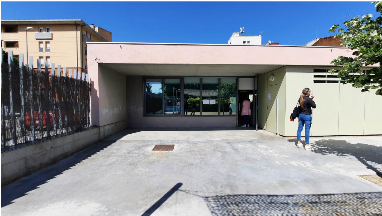
Vista del pati i edifici d'infantil en el punt d'intervenció, per tal de generar l'accés a l'Escola Bressol.
