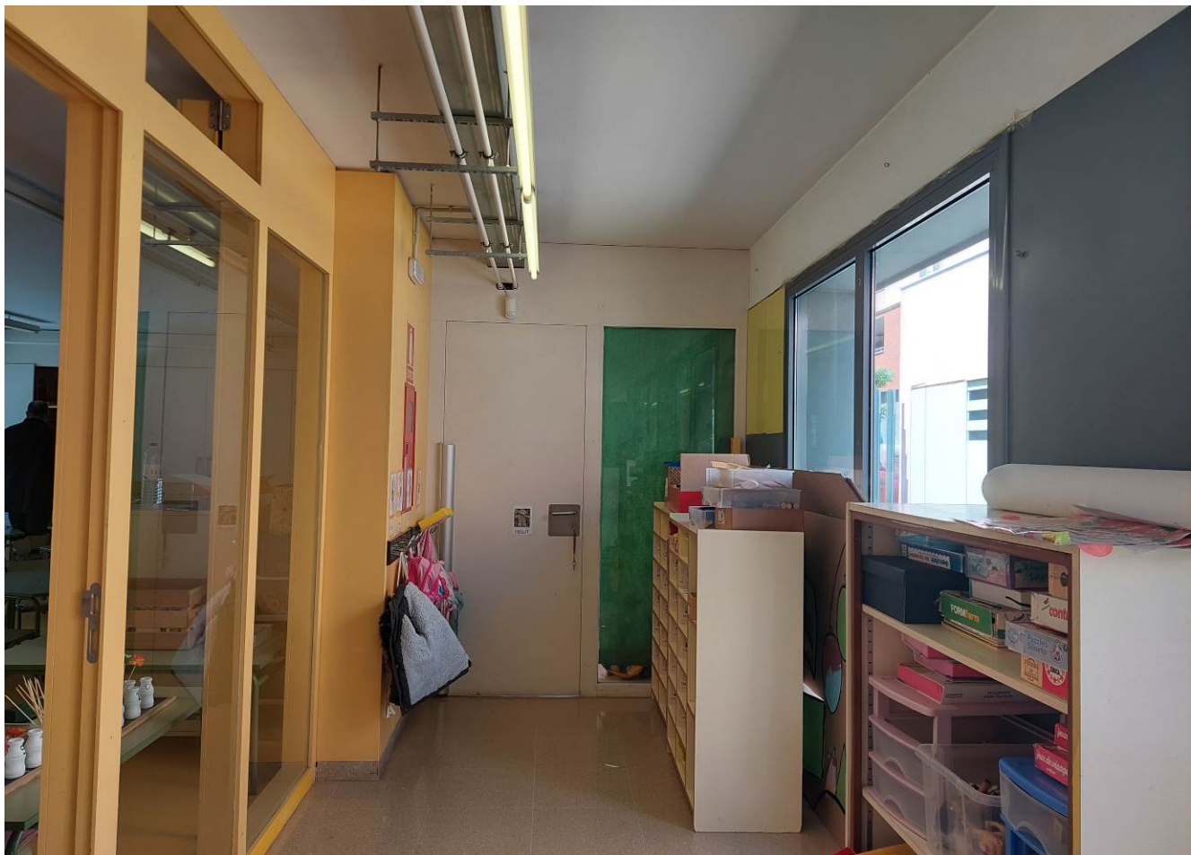
Passadís d'infantil en la zona d'intervenció. Espai de tutoria a anul.lar per a generar l'accés a l'Escola Bressol des de l'exterior.
