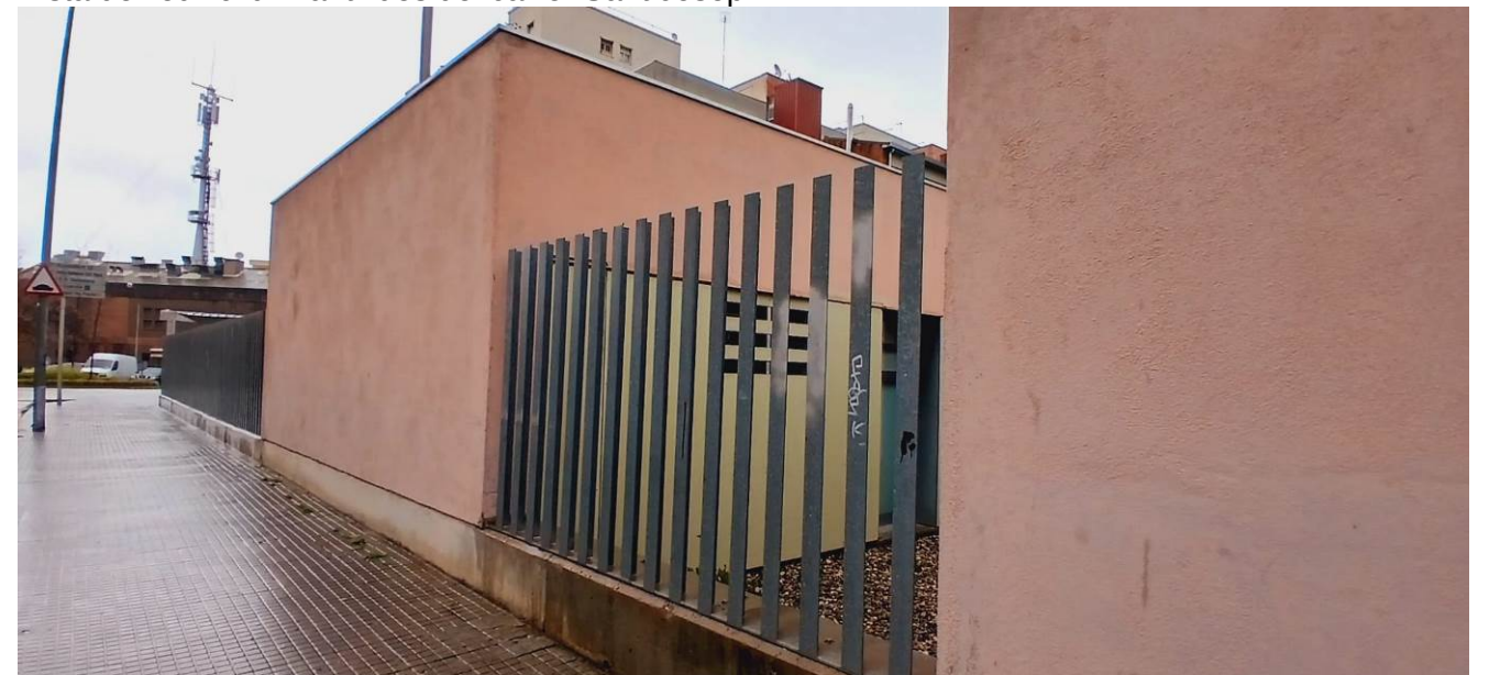
Vista de l'edifici d'infantil des del carrer Sant Josep.
