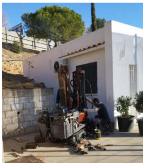
Fotografia 5. Emplaçament del sondeig a rotació S-1R.
