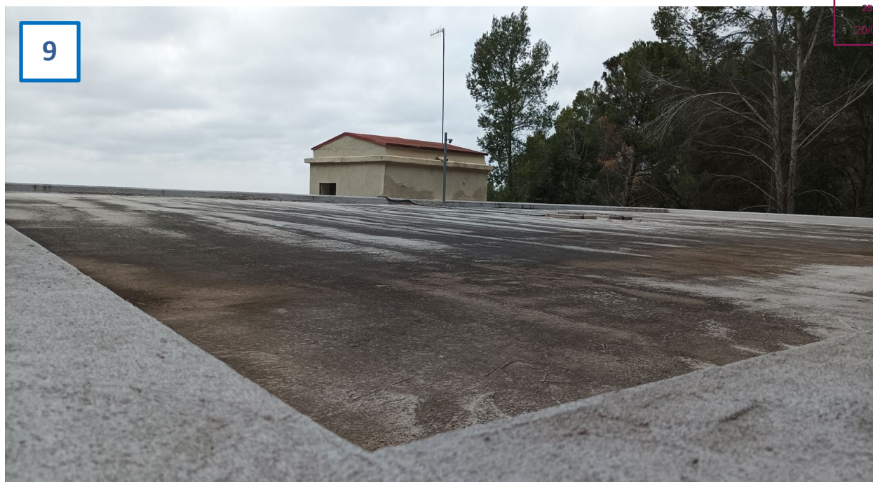
Imatge 9. Coberta vista desde zona nord
