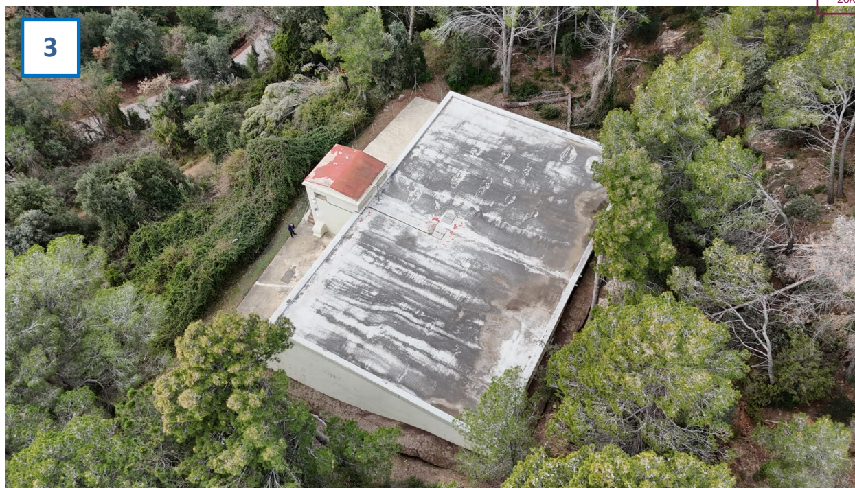
Imatge 3. Vista general de la instal·lació fotovoltaica cobertes dipòsits
