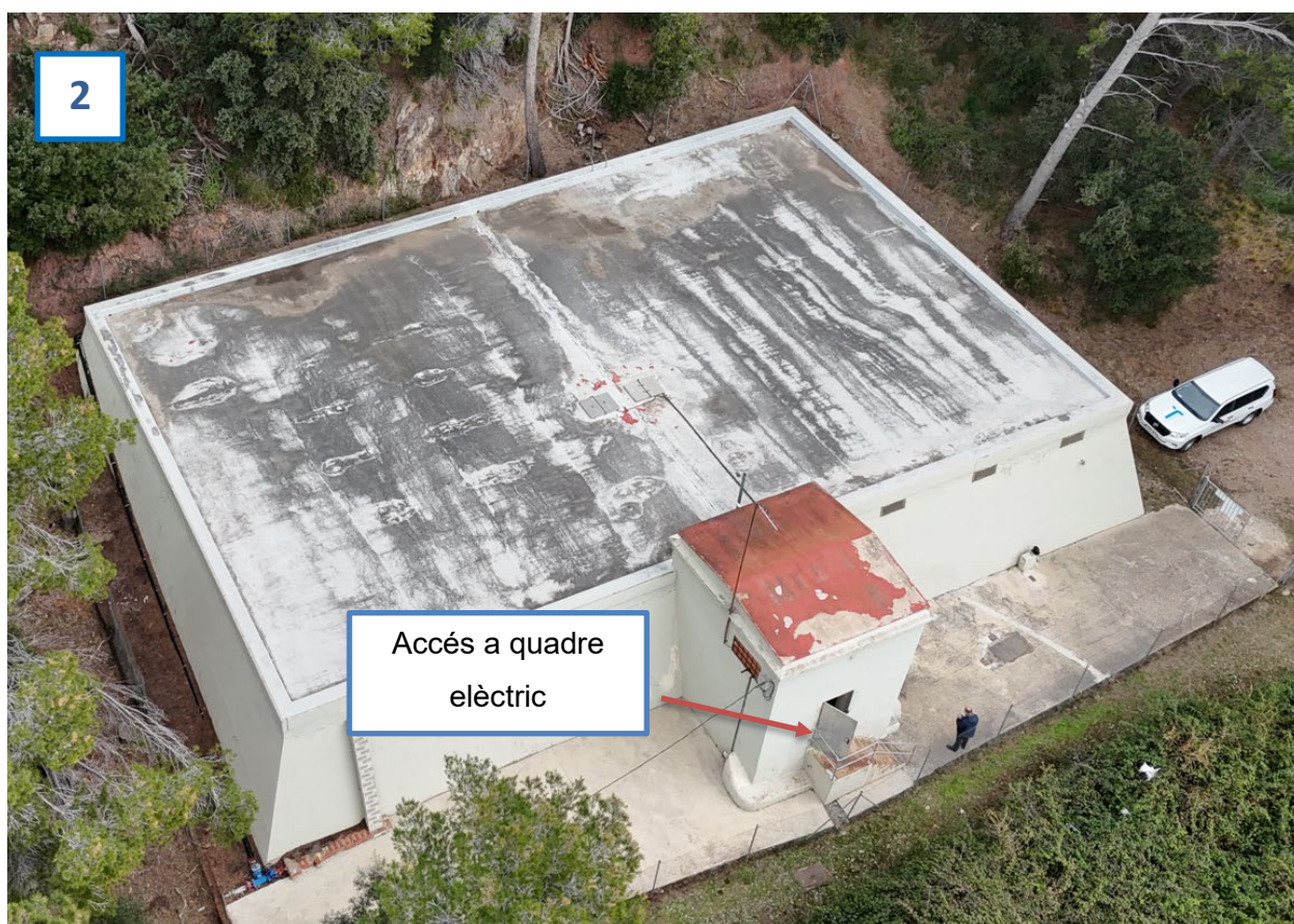
Imatge 2. Vista general de la zona de la instal·lació sobre dipòsit
