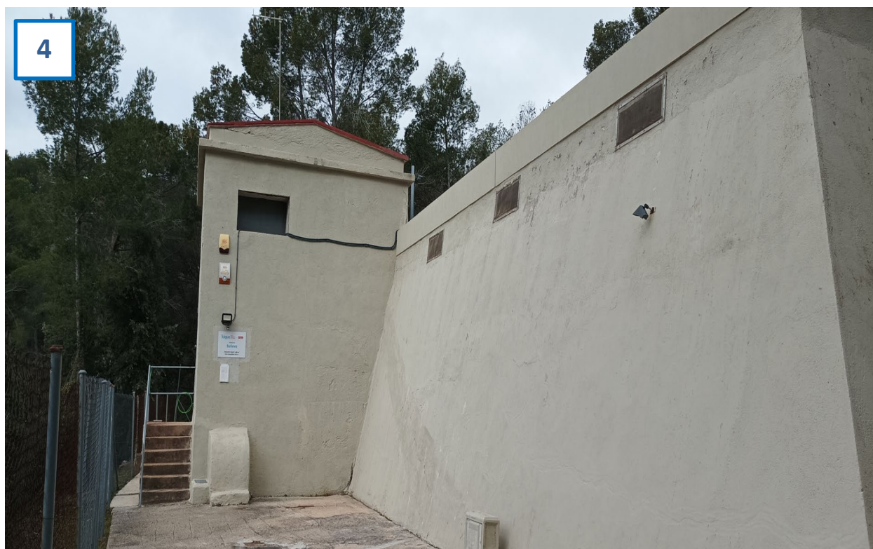
Imatge 4. Vista entrada recinte dipòsits
