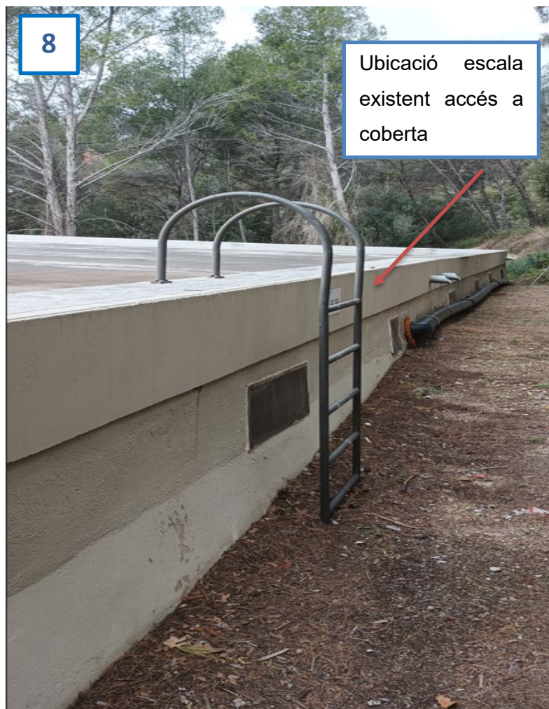
Imatge 8. Detall ubicació escala existent accés a coberta
