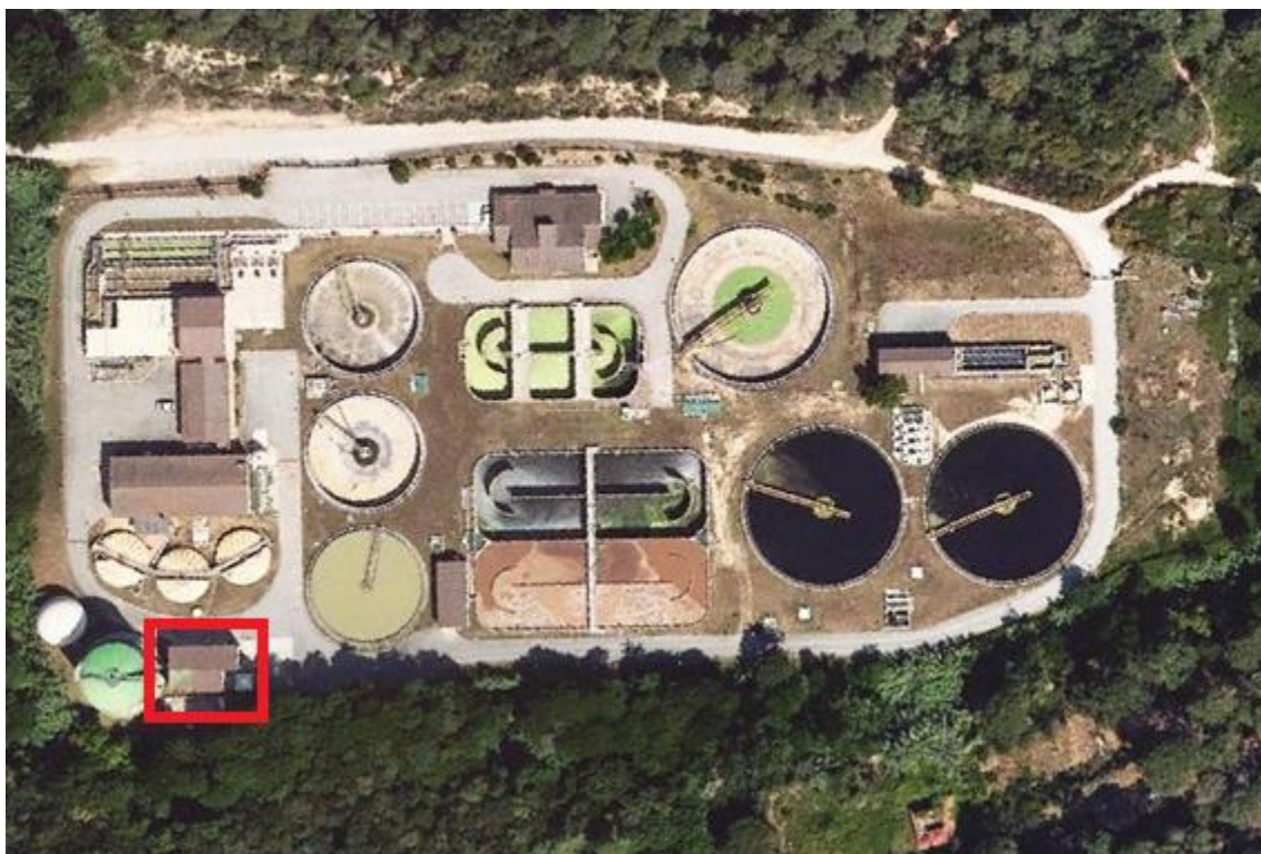
Figura 2. Ubicació de la sala de les calderes dins del recinte de l'EDAR de Lloret de Mar.
