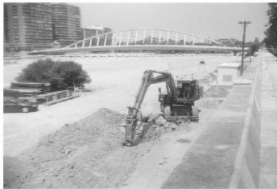
DEMOLICIÓN MECÁNICA A CIELO ABIERTO
