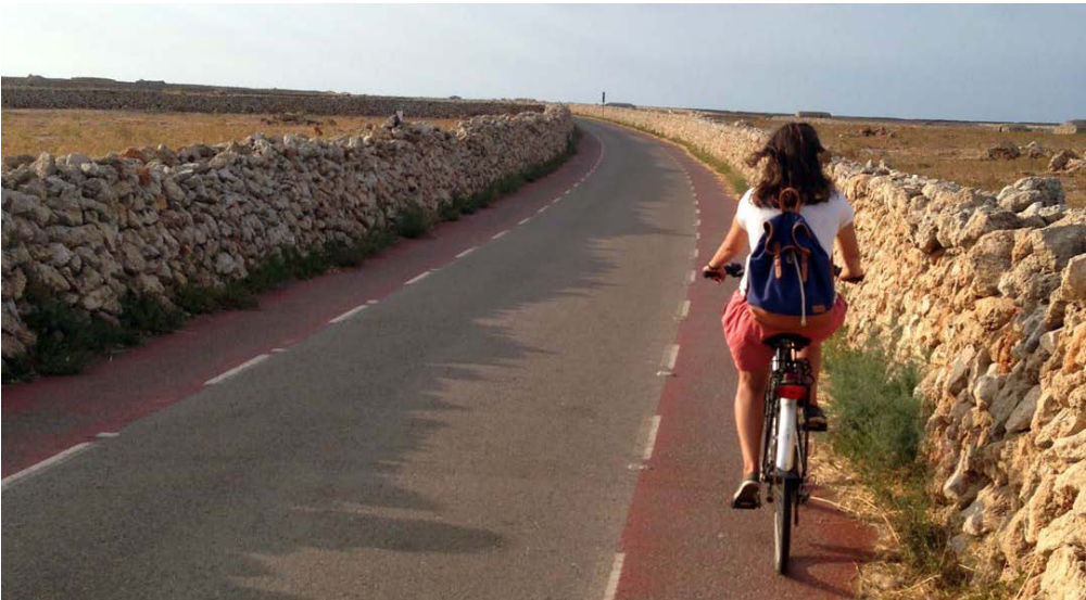
Fotografía 4.21 Banda de protección en plataforma muy estrecha
