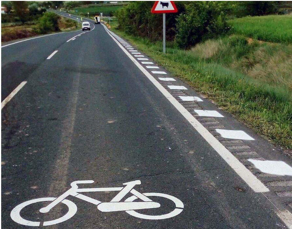
Fotografía 4.23 Acondicionamiento de carril con refuerzo de la señalización ciclista en carretera interurbana
