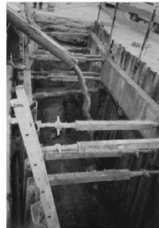
VERTIDO DE HORMIGÓN DE RECUBRIMIENTO
