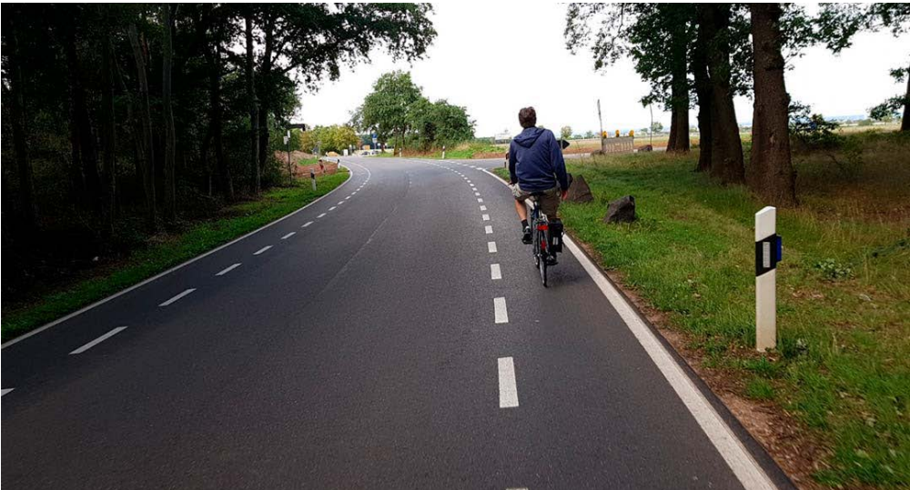
Fotografía 4.21 Banda de protección en plataforma muy estrecha
