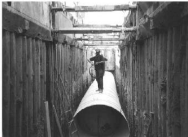
COLOCACIÓN TUBERÍA DE PVC. (RIB-LOC)
