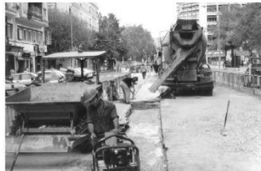
VERTIDO DE HORMIGÓN DE FIRME
