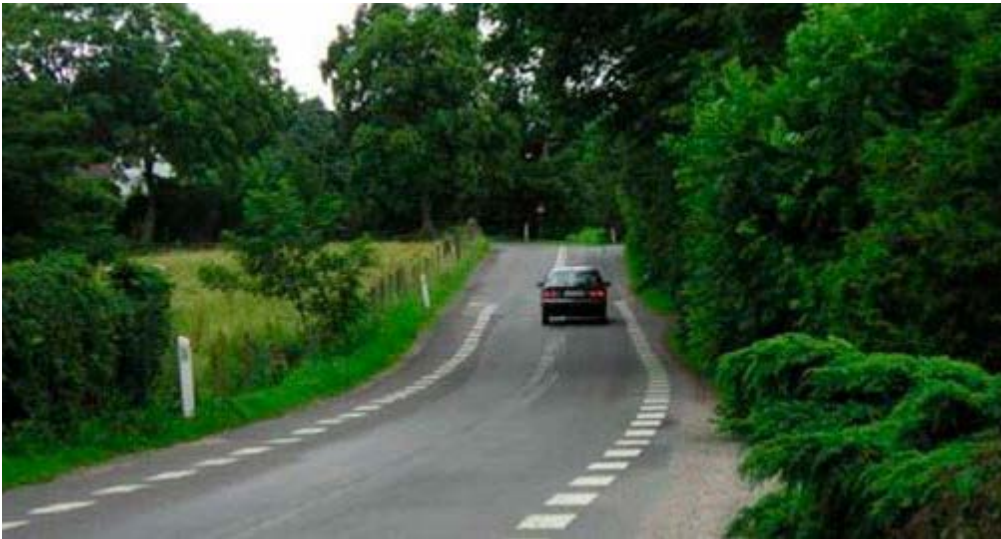
Fotografía 4.20 Supresión de bandas de protección y recuperación del eje en situación de poca visibilidad
