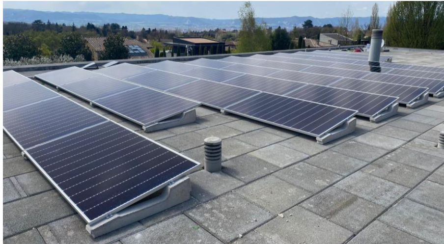
Figura 4: Estructura triangular sobre coberta plana
