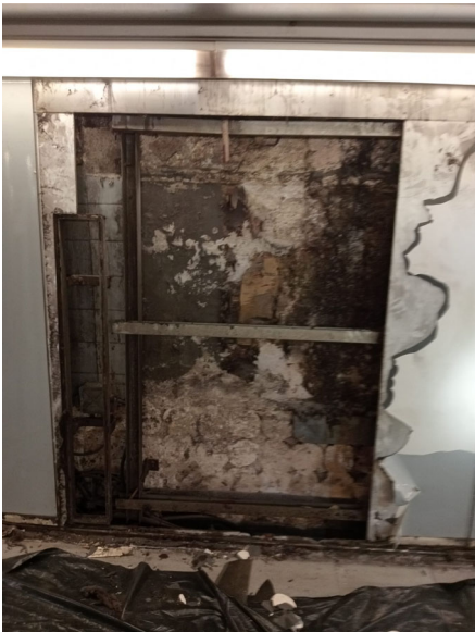
Espai darrere placa de fibrociment retirada
