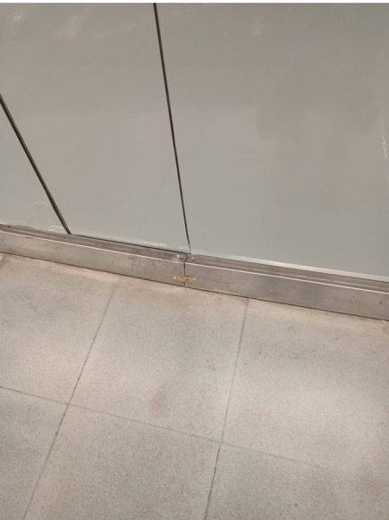
Per al procés de retirada, cal desmuntar 1er el sòcol inferior, 2on lluminàries i embellidor superior
