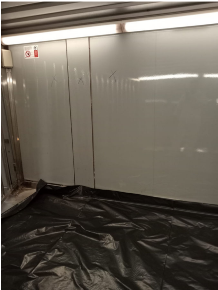
Per al procés de retirada, cal desmuntar 1er el sòcol inferior, 2on lluminàries i embellidor superior
