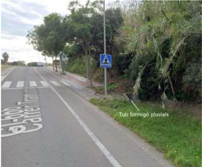
Figura 2. Boca de sortida de les aigües pluvials provinents del C/Puig del Molí i C/Girasol
