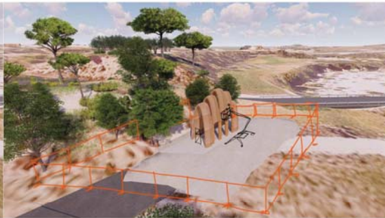
07 EXECUCIÓ DE VOLTA Segons l'ordre previst. Tres capes cada volta. Execució de reforç estructural entre 2a i 3a capa segons detalls. Remats finals de l'obra de maó. Aplicació hidrofugant
