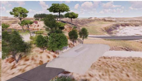
03 TERRAPLENAT I PLATAFORMA DE TREBALL Terraplenat nucli interior amb graves Terraplenat exterior amb terra esmenada Compactació. Replanteig voltes i ríostres/ pous de fonamentació
