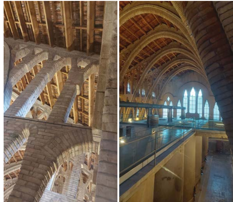
Cellar de El Pinell de Brai
