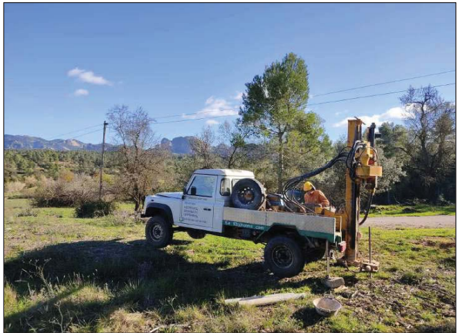
Emplaçament del penetròmetre P-1.
