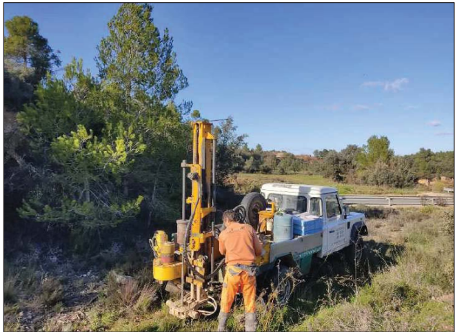
Emplaçament del penetròmetre P-2.
