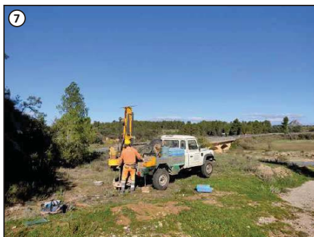
Emplaçament del penetròmetre P-1.
