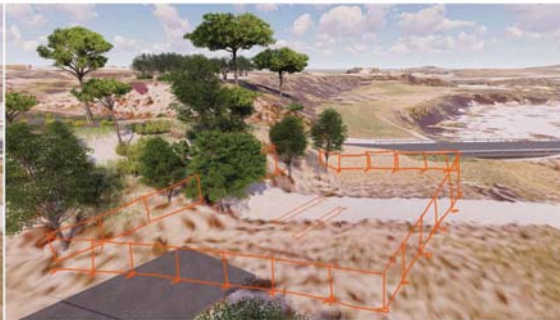
02 IMPLANTACIÓ DE L'OBRA Protecció de la vegetació existent. Tancament de l'obra, camp d'obra. Replanteig. Excavació de les sabates de fonamentació fins l'estrat resistent
