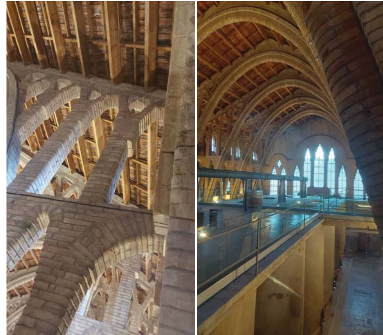
Cellar de El Pinell de Brai
