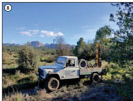
Emplaçament del penetròmetre P-2.
