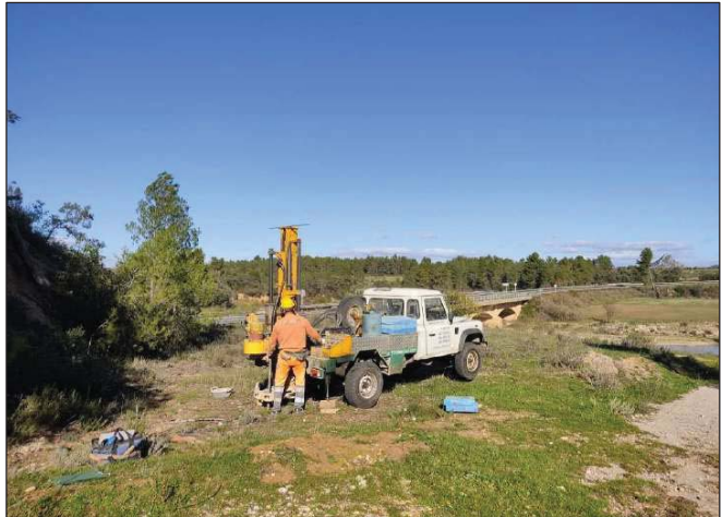
Emplaçament del penetròmetre P-1.
