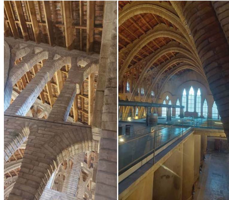
Cellar de El Pinell de Brai
