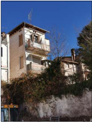
VISTA FAÇANA POSTERIOR N°16-18
