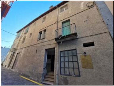
VISTA FAÇANA PRINCIPAL N°18
