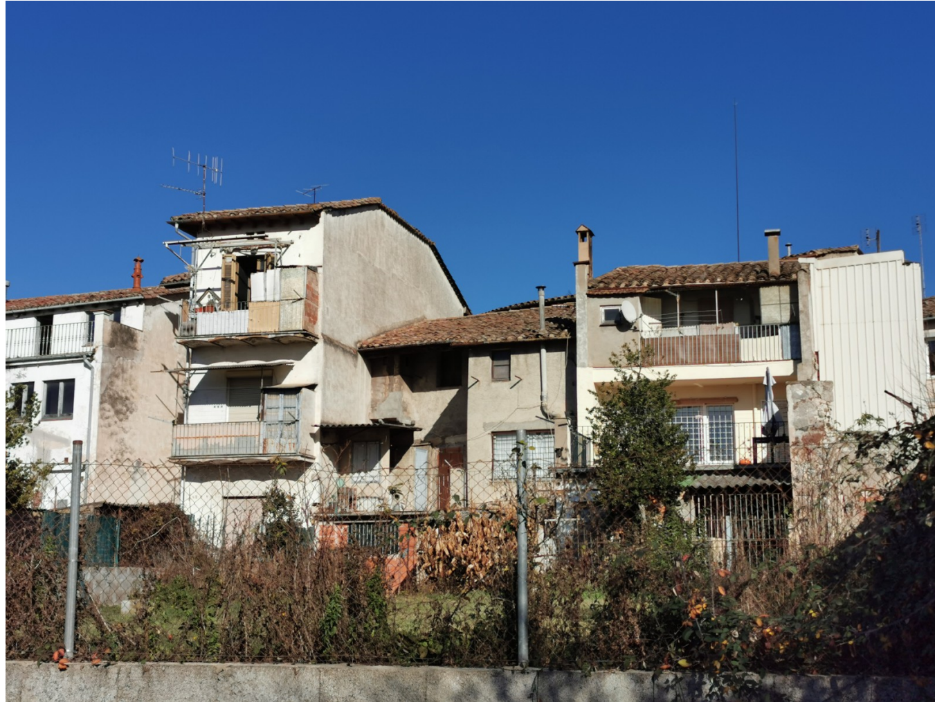
Façanes posteriors edificacions carrer Sant Cristofor 16-18
