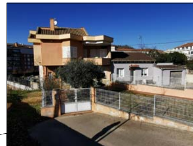
VISTA FAÇANA PRINCIPAL N°8-10
