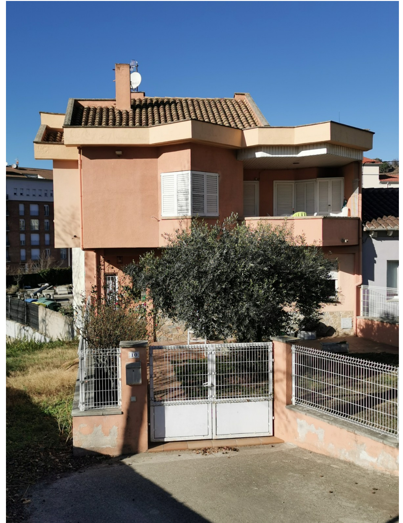
Edificació camí de la Creu 10
