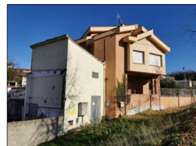
VISTA DEL CT i FAÇANA LATERAL N°10
