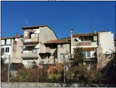
VISTA FAÇANA POSTERIOR N°16-18
