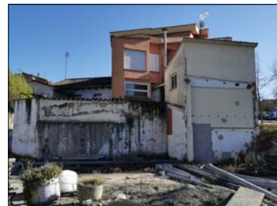
VISTA FAÇANA POSTERIOR CT i N°8-10
