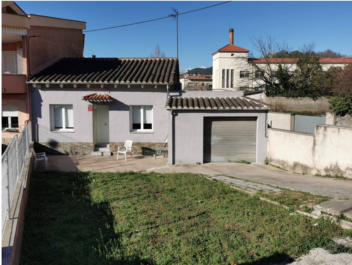
Edificació camí de la Creu 8
