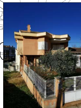
VISTA FAÇANA PRINCIPAL N°10
