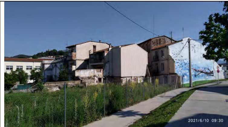
Línia aèria al camí de la Creu, procedent de l'ET
