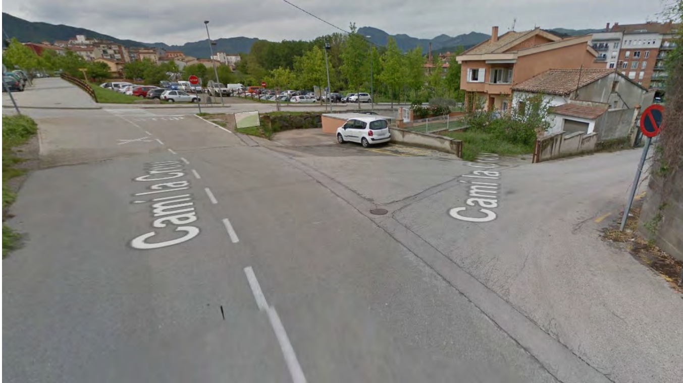
En aquesta foto, prèvia a les obres de reurbanització, s'observa la traça que seguia i manté la canonada d'aigua (Font: Google Maps)
