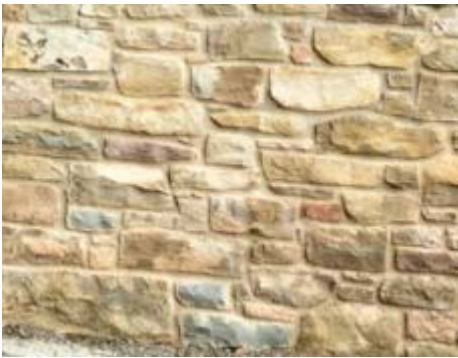
Aplacat de pedra en murs exteriors
