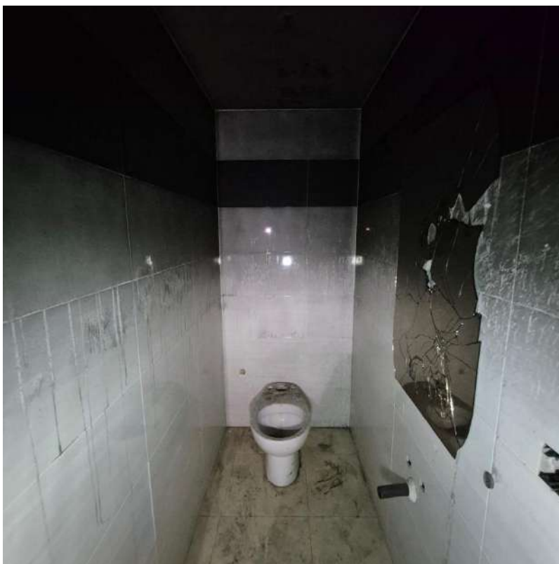
Interior edifici - Habitatge Planta segona - Servei
