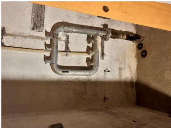
Absència montants aigua
