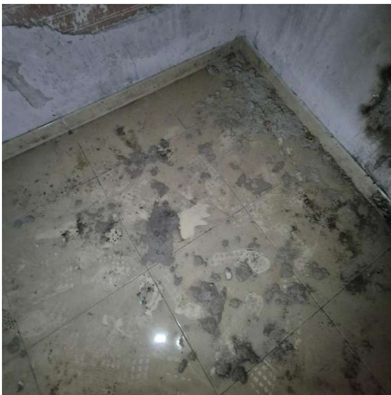
Interior edifici - Habitatge Planta segona - Habitació 02
