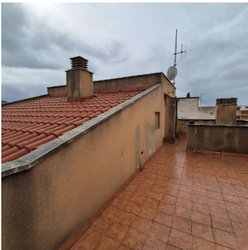
Interior edifici - Zones comuns - Terrassa Planta sotacoberta
