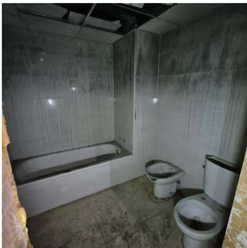
Interior edifici - Habitatge Planta segona - Bany
