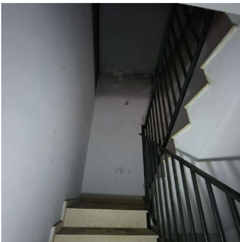
Interior edifici - Zones comuns - Escales Planta tercera
