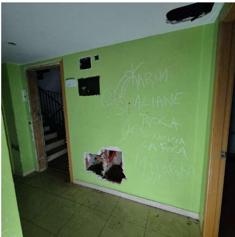
Interior edifici - Habitatge Planta tercera - Rebedor i quadres instal·lacions
