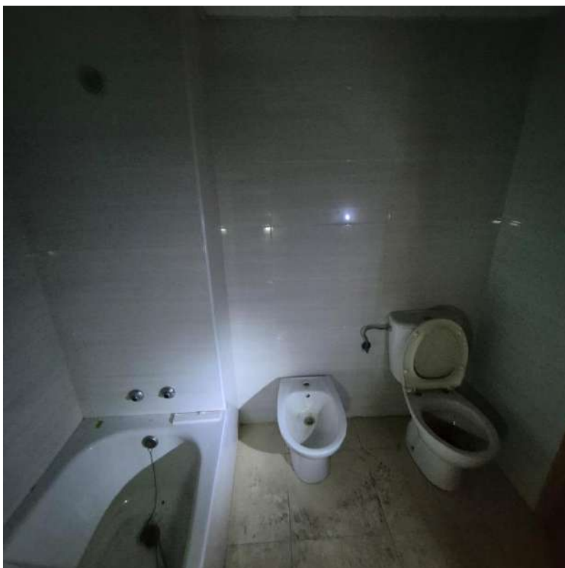
Interior edifici - Habitatge Planta baixa - Bany
