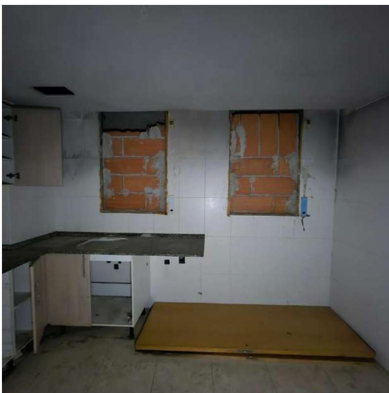
Interior edifici - Habitatge Planta segona - Cuina
