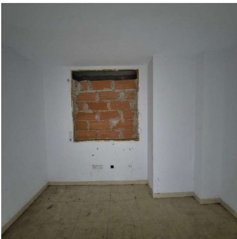
Interior edifici - Habitatge Planta segona - Habitació 03
