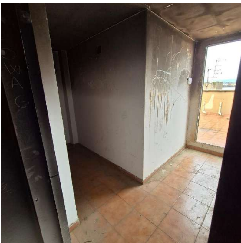
Interior edifici - Zones comuns - Pas Planta sotacoberta
