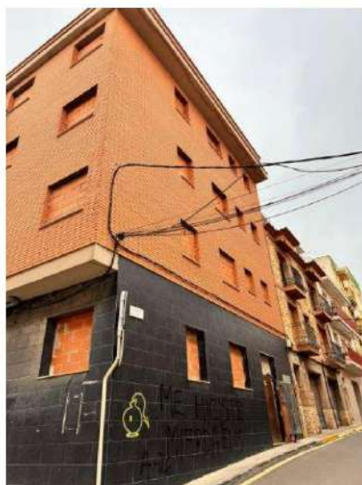
Façana carrer Vint-i-cinc
