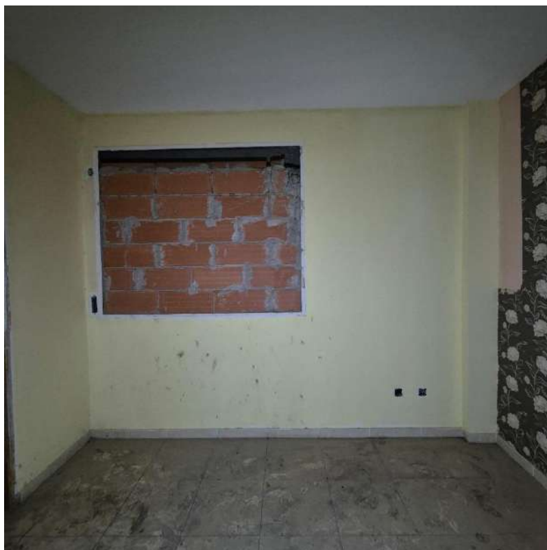
Interior edifici - Habitatge Planta baixa - Menjador
