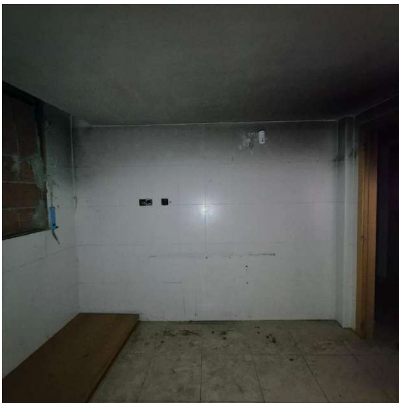
Interior edifici - Habitatge Planta segona - Cuina
