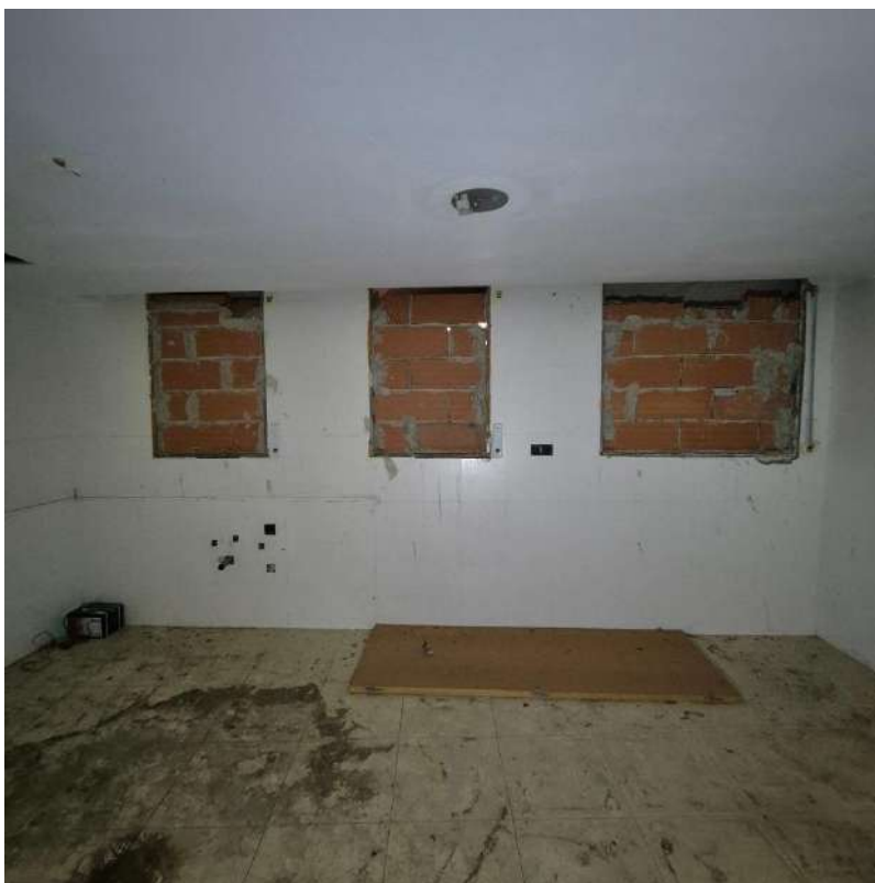
Interior edifici - Habitatge Planta tercera - Cuina
