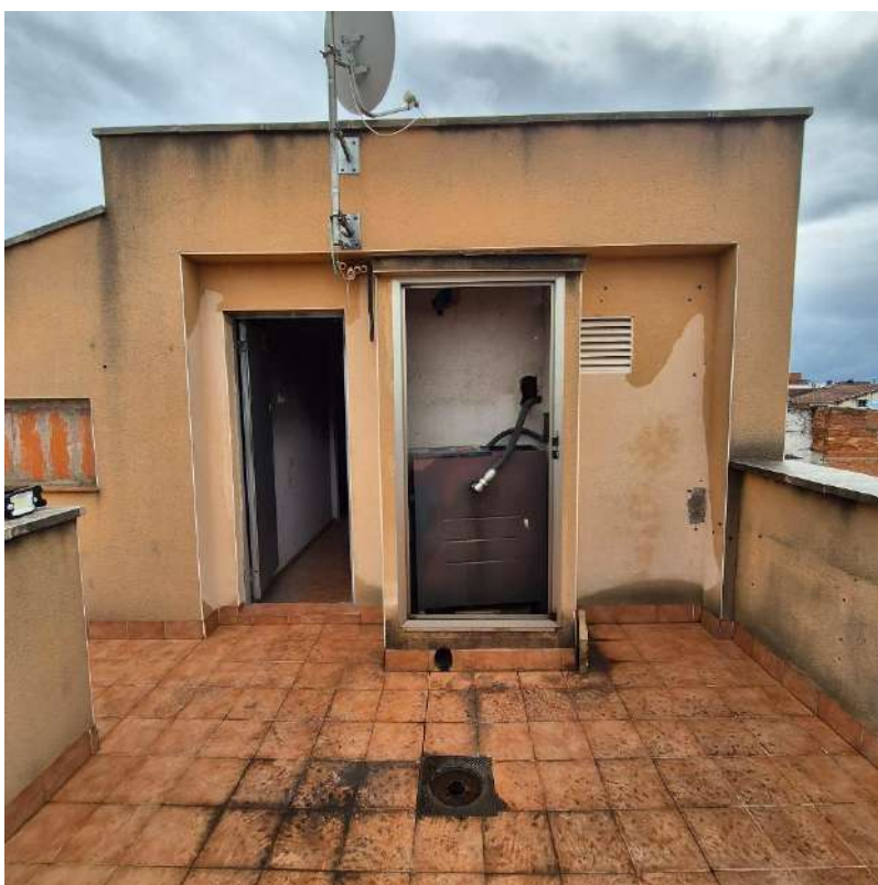
Interior edifici - Zones comuns - Terrassa Planta sotacoberta
