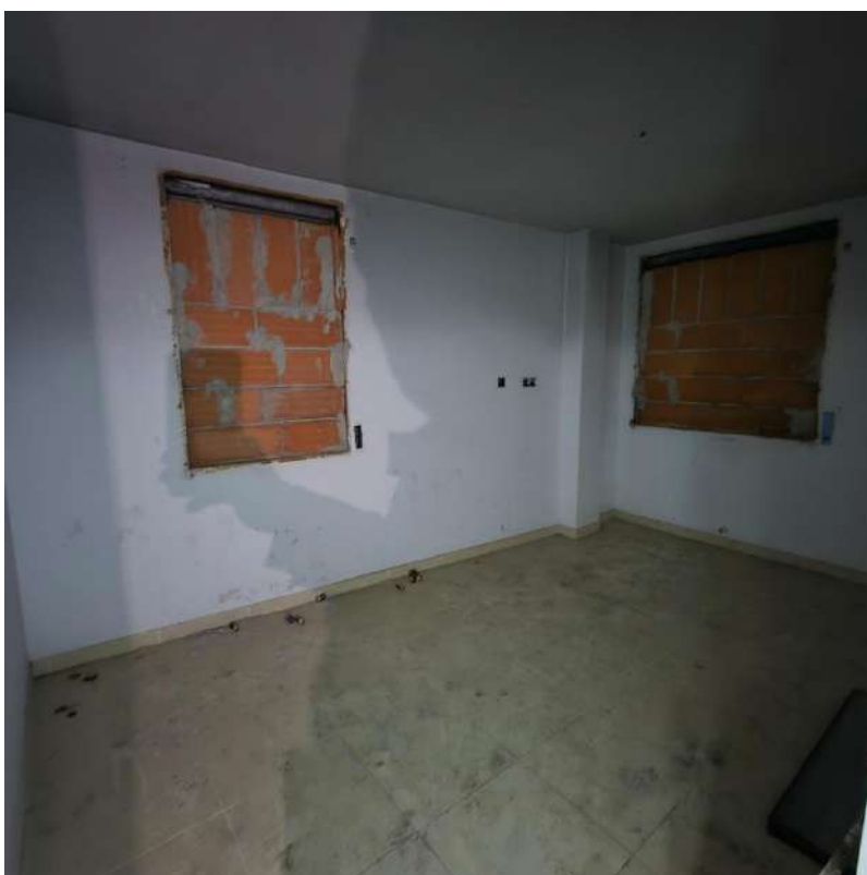
Interior edifici - Habitatge Planta segona - Habitació 01
