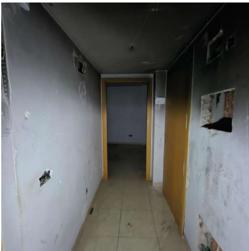
Interior edifici - Habitatge Planta segona - Rebedor
