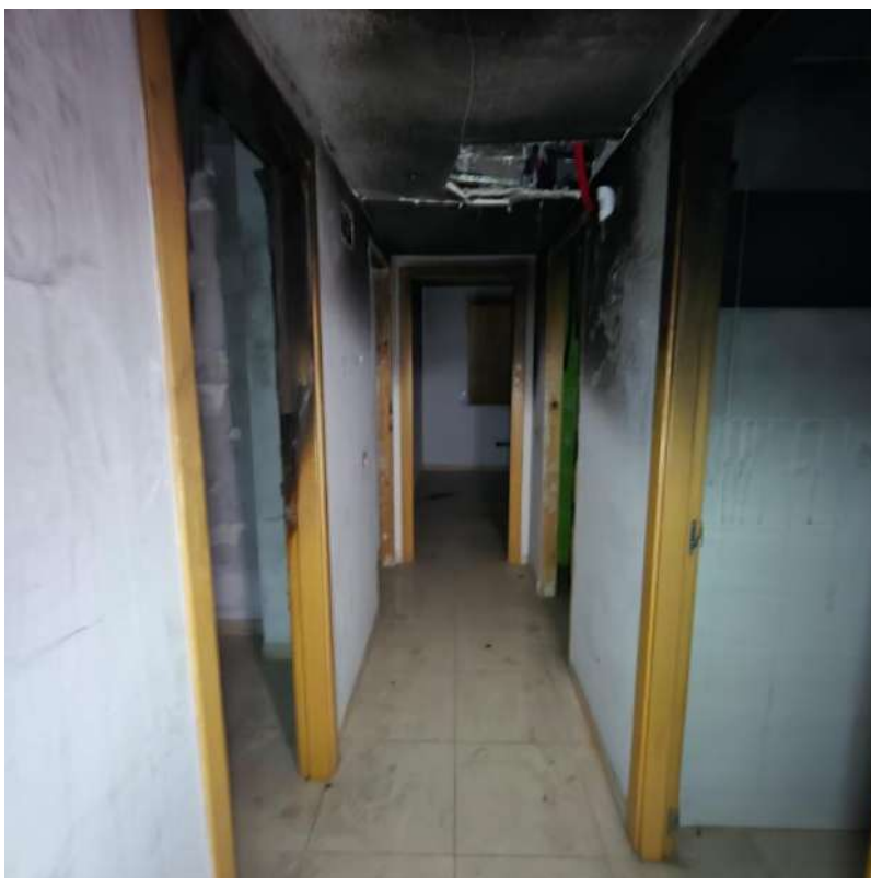
Interior edifici - Habitatge Planta segona - Pas
