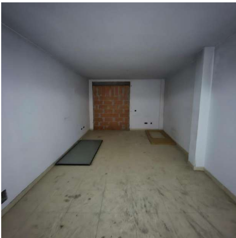
Interior edifici - Habitatge Planta segona - Menjador
