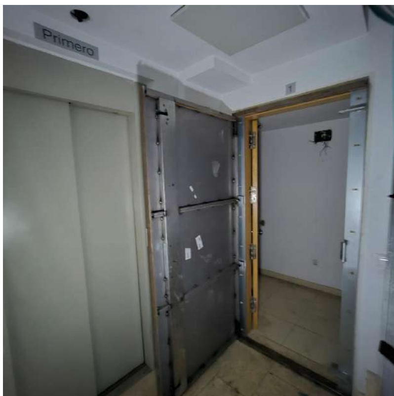
Interior edifici - Habitatge Planta primera - Porta d'entrada
