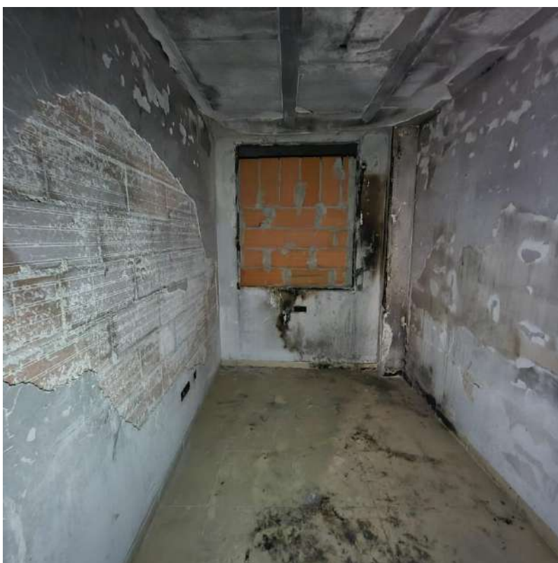
Interior edifici - Habitatge Planta segona - Habitació 02
