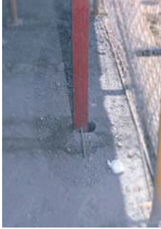
Recolzament inferior sostre
