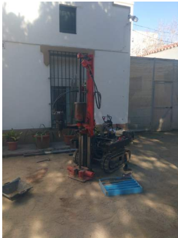
Sonda de perforació durant la realització del sondeig.
