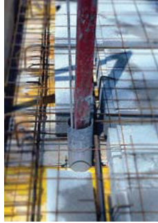
Paso interior en sostre
