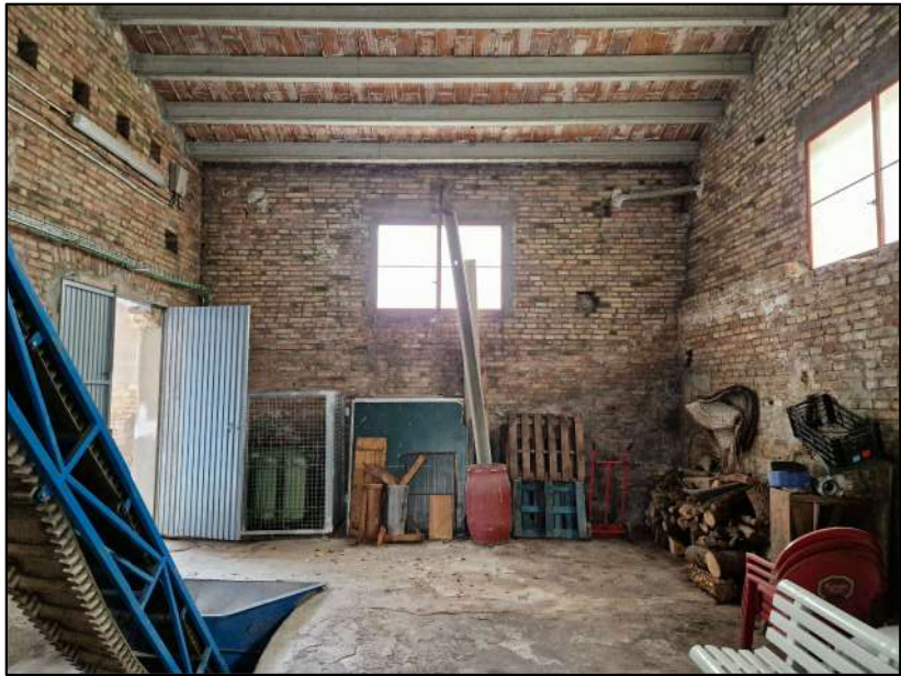
IMATGE 1. VISTA GENERAL DE L'ENTRADA
