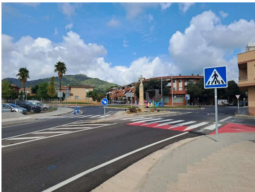
8.- Carretera TP-7013 (Avinguda de la Fraternitat)
