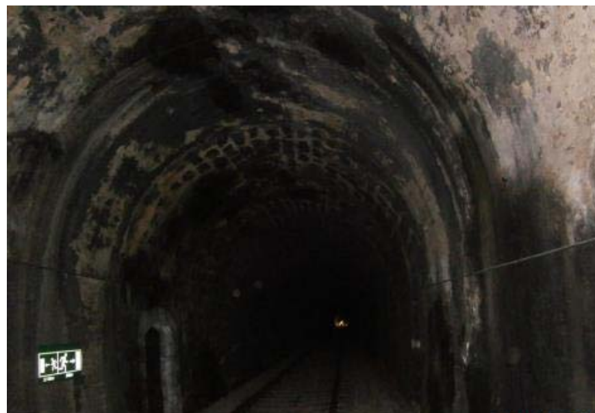
Vista d'un tram del túnel
