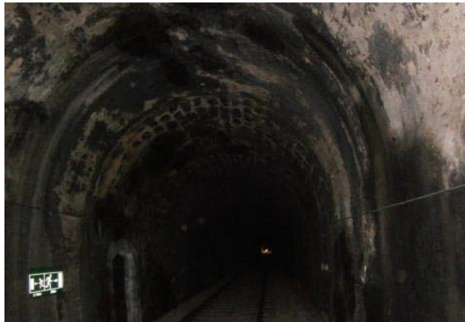
Vista d'un tram del túnel
