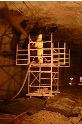
BASTIDES PER REPARACIÓ FISSURES EN VOLTA I LAMINA IMPERMEABILITZANT
