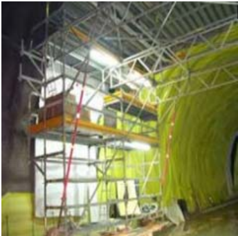
BASTIDES PER REPARACIÓ FISSURES EN VOLTA I LAMINA IMPERMEABILITZANT
