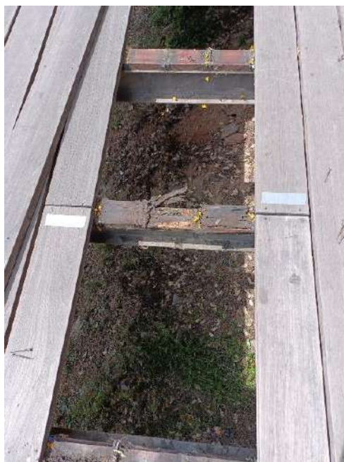
Situació dels rastrells en mal estat, sobre els que es recolzen els taulons d'acabat.
