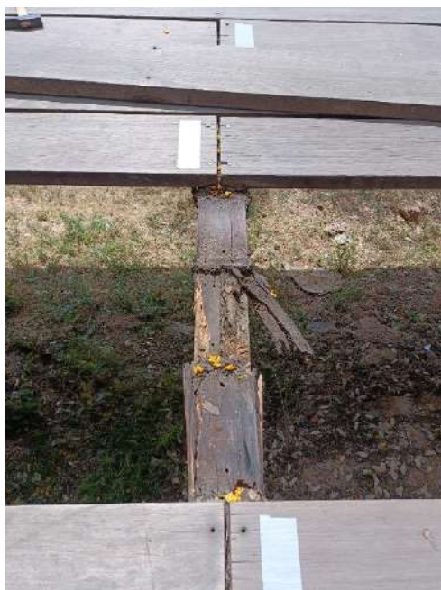
Situació dels rastrells en mal estat, sobre els que es recolzen els taulons d'acabat.
