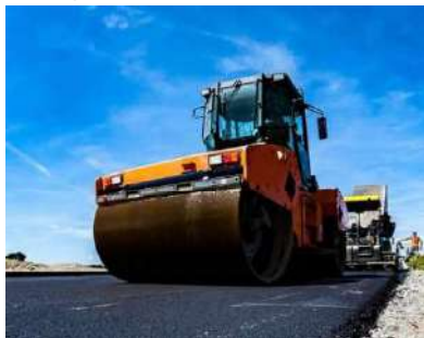
Figura 7. Màquina estenedora de paviment
