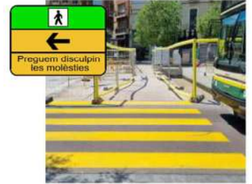
Figura 10. Pas de vianants afectat per les obres
