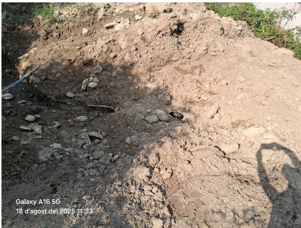
Fotografia 2 Tram a subsituir clavoguero formigo per PE.
