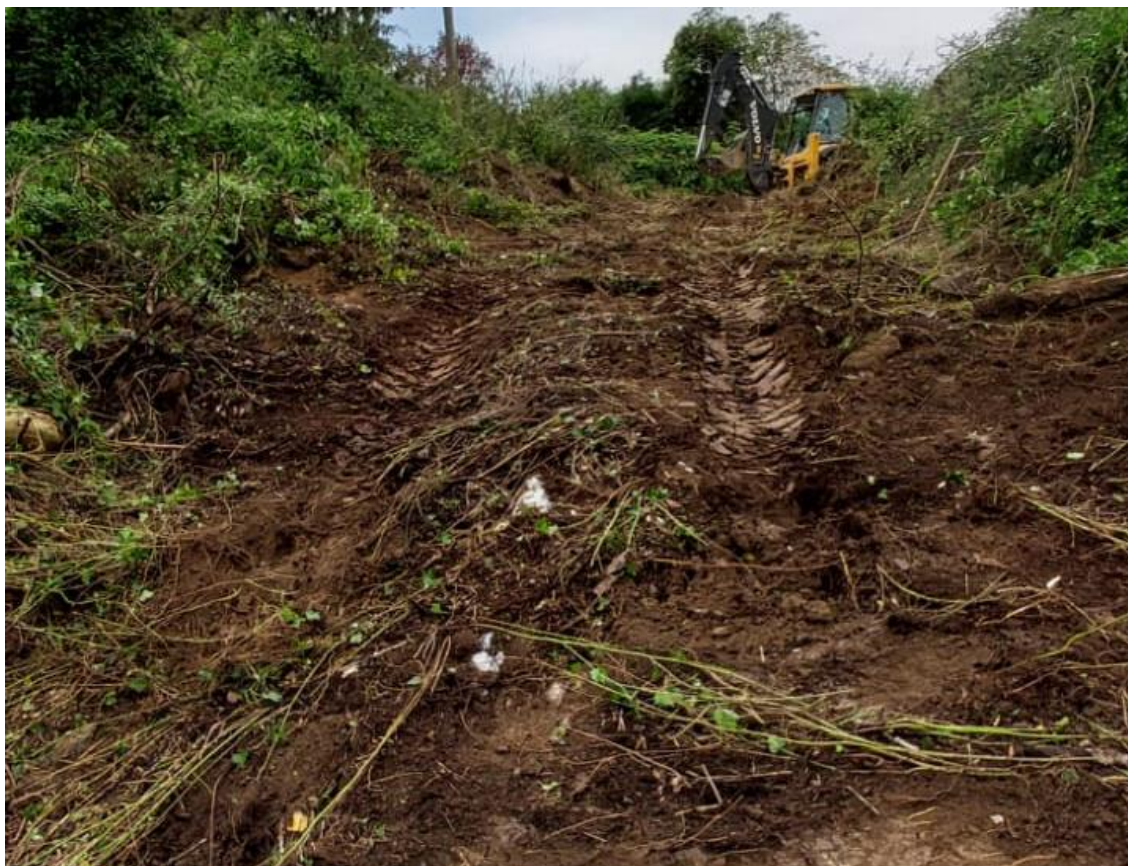
Fotografia 4 Tram de pvc a mantenir fins a pou en alta
