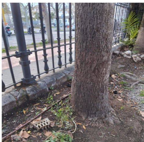
Imatge 31.- Exemplar E23, afectació forja. Font: Pròpia
