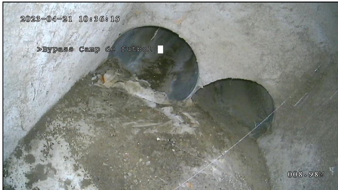
Abocament dels dos tubs de by-pass procedents del registre DPSE-PR-0110 al registre cec
