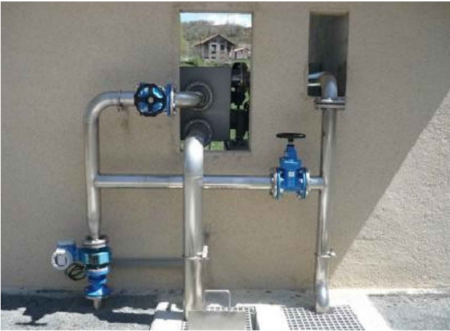
Cabalímetre EB 2 Pobla a substituir
