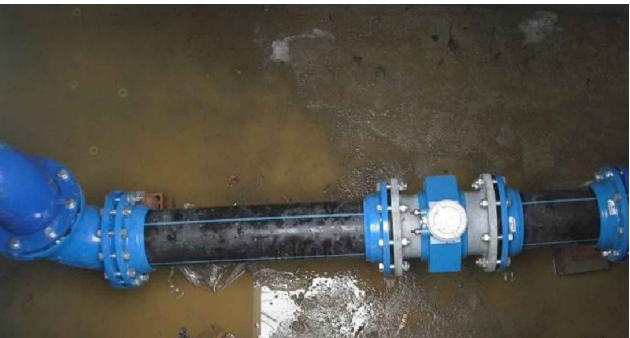
Cabalímetre EB 2 Pobla a substituir
