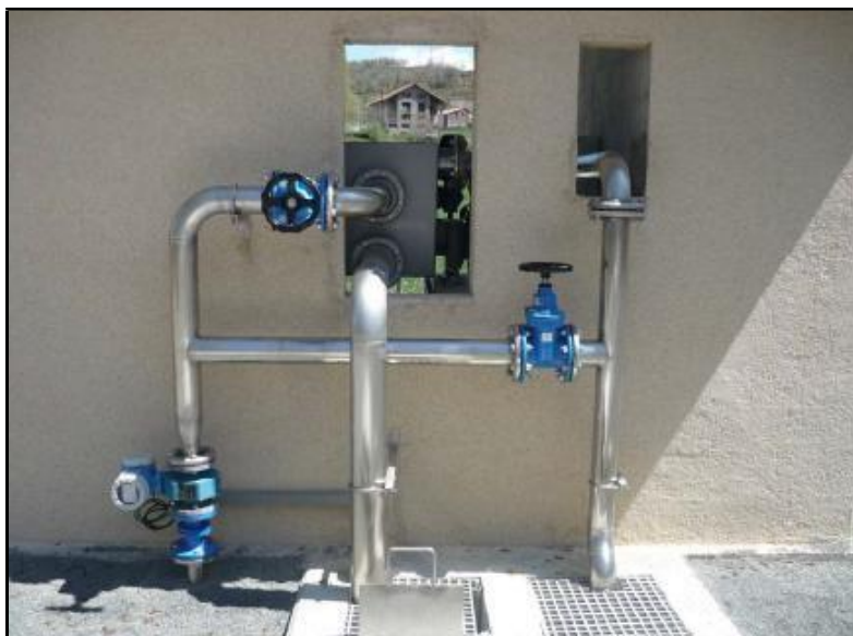
Imatge de la instal·lació de canonades del pretractament de l'EDAR de La Pobleta de Bellveí, on s'ubica el cabalímetre d'entrada, en el moment de la seva instal·lació l'any 2011
