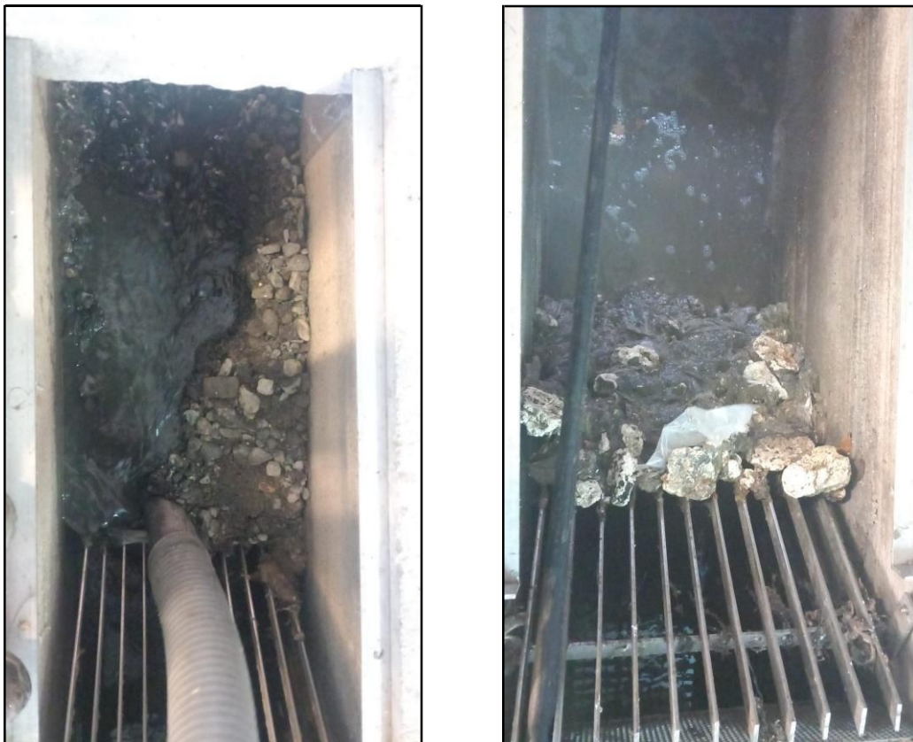
Imatges de les tasques de neteja i succió de graves i sorres a l'EDAR d'Isona
