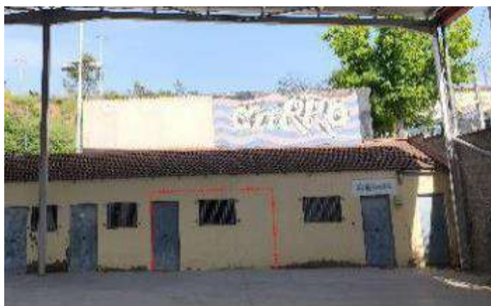
Imatge 6 – Àmbit obertura antics vestidors (Font: realització pròpia)
